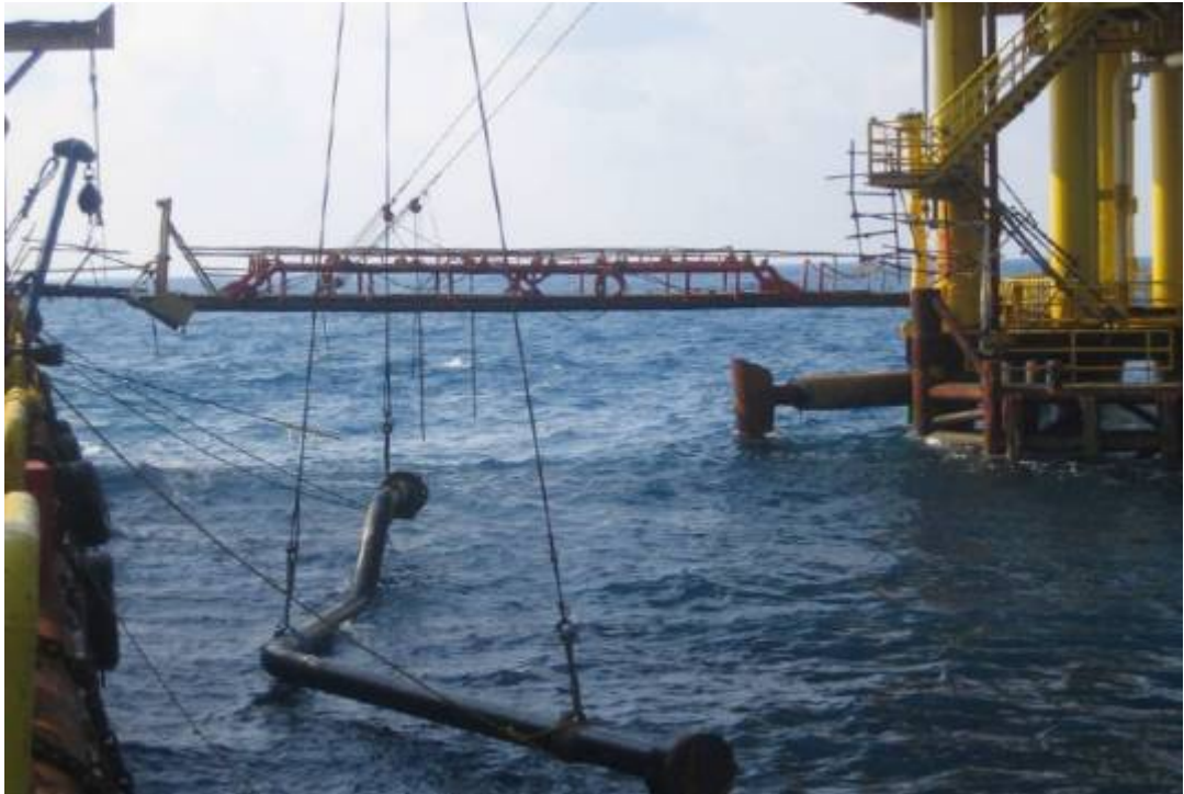
Figura 7.s: Installazione Spool (Edison, 2011f)
