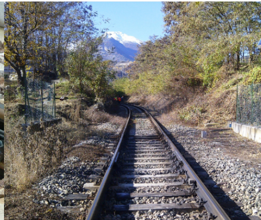
Impianto lubrificazione P.A.L. Italia (Foto: P.A.L. Italia; 2012)
