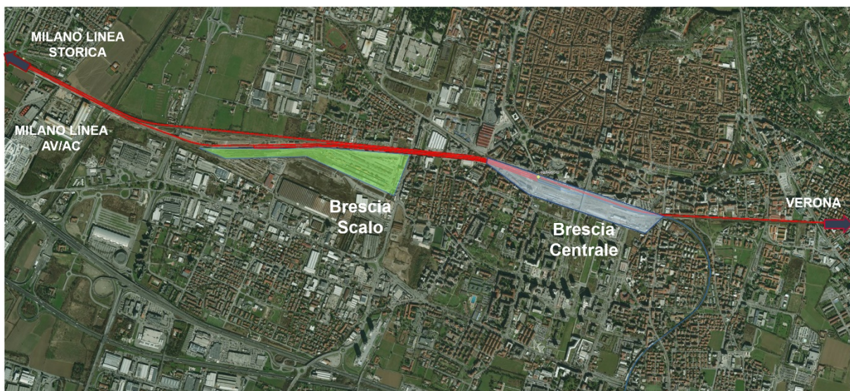
Figura 3-1 Vista aerea dell'inquadramento generale dell'intervento oggetto di studio
