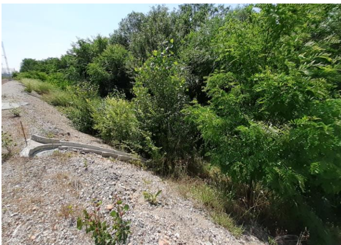
Figura 77 Foto1 Embrice di scarico delle acque nel fosso di drenaggio ai piedi del rilievo
