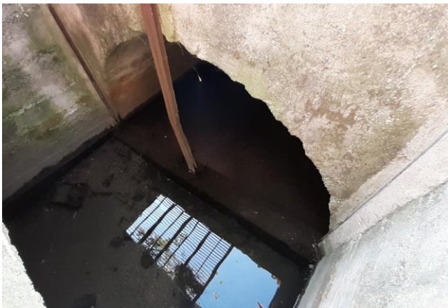
IN04 – Vista dall'alto del manufatto a valle dell'attraversamento ferroviario – vista verso valle
