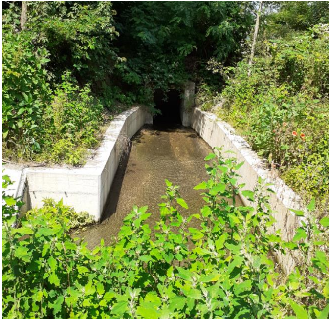
IN01 – Tratto a valle dell'attraversamento ferroviario-vista verso monte
