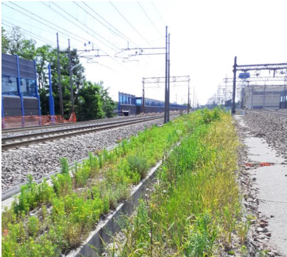
Figura 61 Fotografia 1 – Canalette di raccolta acque meteoriche
