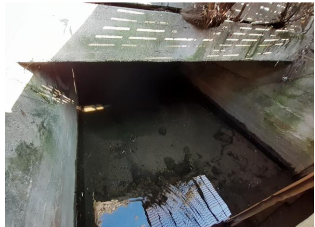
IN04 – Vista dall'alto del manufatto a valle dell'attraversamento ferroviario – vista verso monte (verso l'attraversamento ferroviario)
