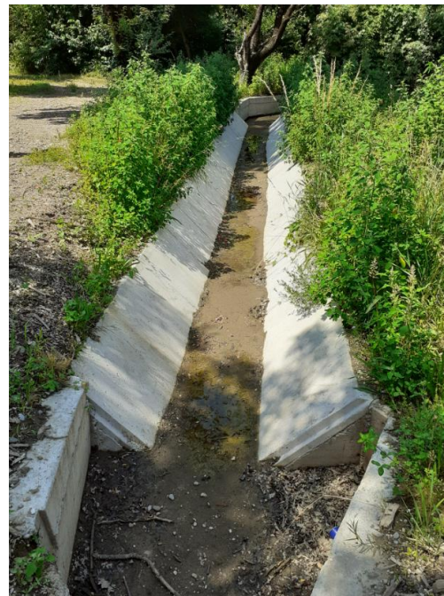
IN01 – Tratto a valle dell'attraversamento ferroviario
