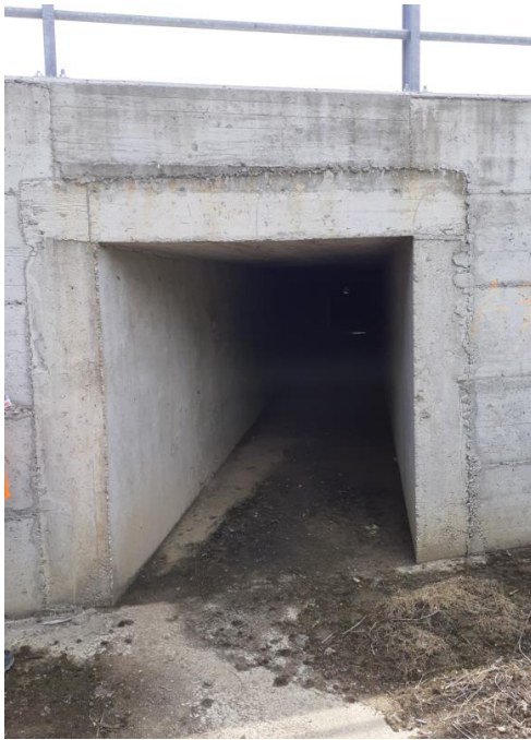
IN03 – Tratto a monte dell'attraversamento ferroviario
