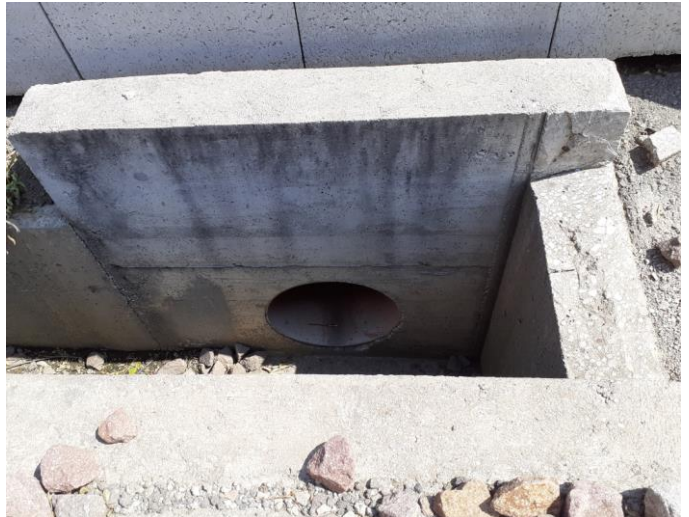
Figura 62 Fotografia 2 – Attraversamento canalette verso i fossi di guardia nel tratto esterno
