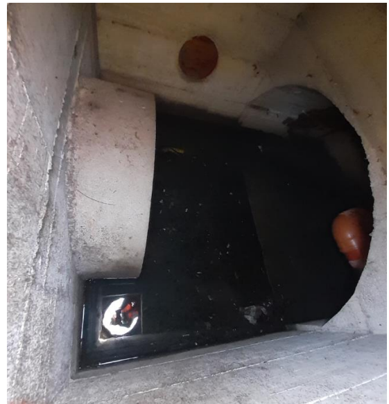
IN04 – Vista dall'alto del manufatto a monte dell'attraversamento ferroviario
