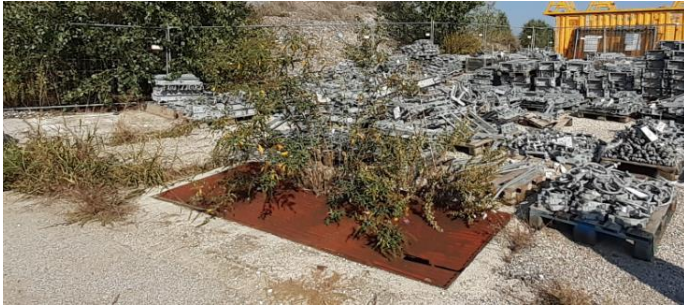
IN04 – Manufatto a valle dell'attraversamento ferroviario
