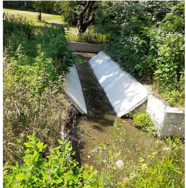
IN01 – Tratto a valle dell'attraversamento ferroviario – vista verso valle
