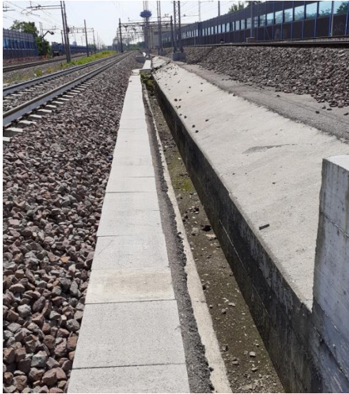
Figura 63 Fotografia 3 – Canalette di raccolta acque meteoriche
