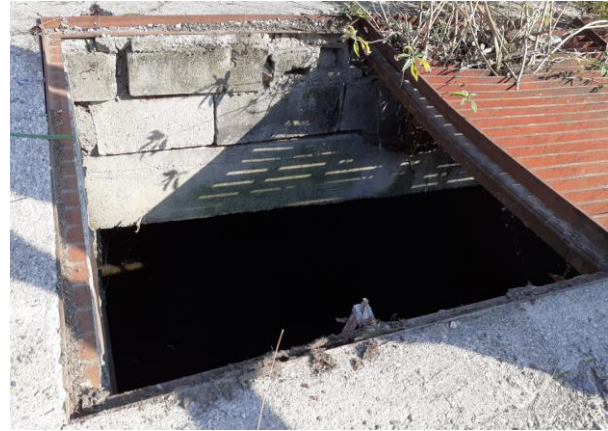
IN04 – Manufatto a valle dell'attraversamento ferroviario
