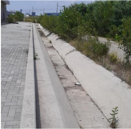
Figura 105 Foto 1 Canalina di drenaggio dei fabbricati realizzati nell'ambito del progetto "Linea A.V./A.C. Milano - Venezia tratta A.C. Milano - Verona ingresso urbano dell'interconnessione di Brescia Ovest"
