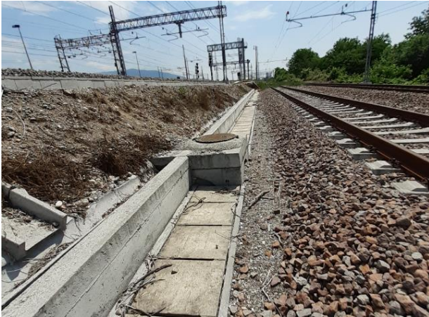
Figura 79 Foto3 Embrice di scolo in una tubazione a u. La canaletta e la tubazione scaricano in un pozzetto e successivamente saranno scaricate nel fosso oltre le linee ferroviarie
