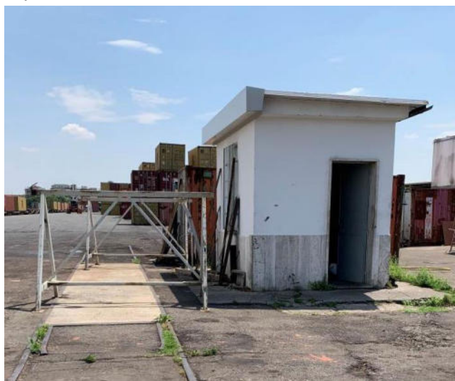
Fabbricato di pesa
