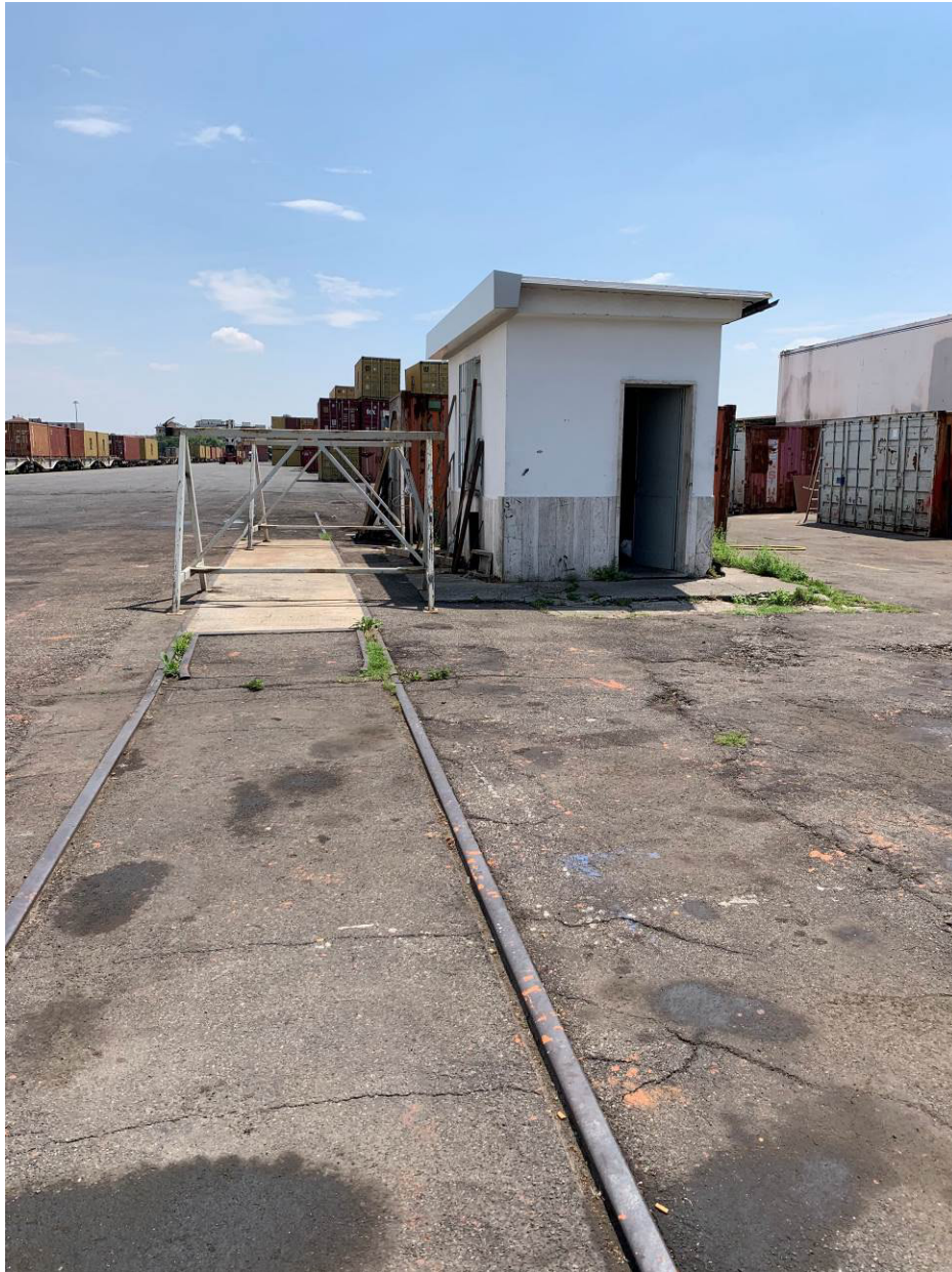
Foto n.8 - Fabbricato di pesa
