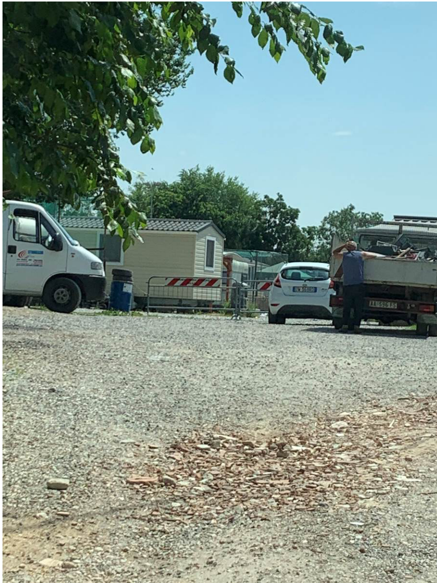
Foto n.5 - Area fabbricati in demolizione
