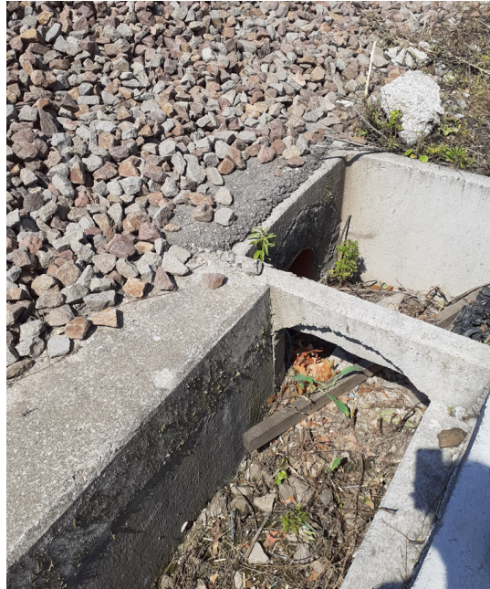
Foto n.10 Attraversamento \Phi 300 in PEAD
