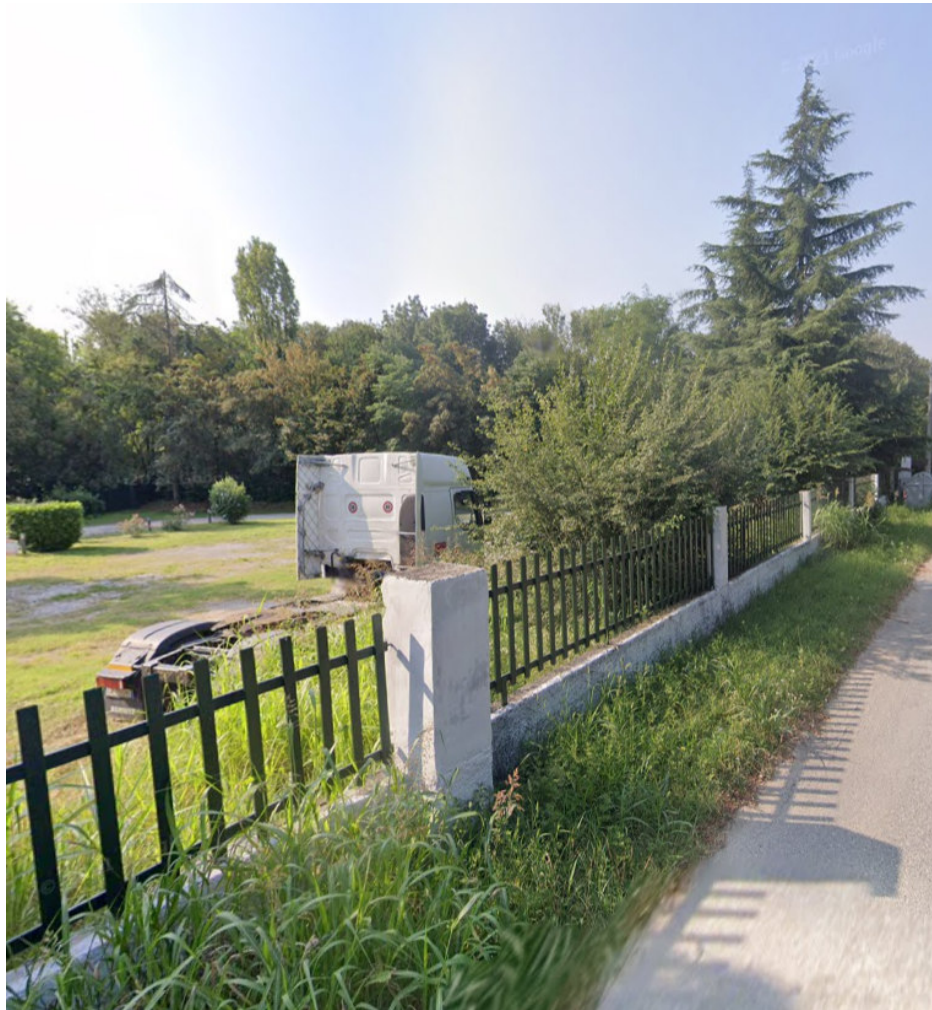
Foto n. 12 Muro di recinzione esistente
