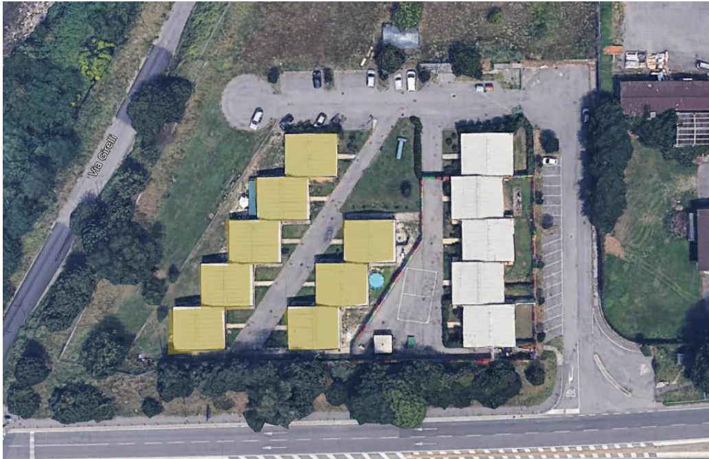
Foto n.3 – Localizzazione fabbricati in demolizione
