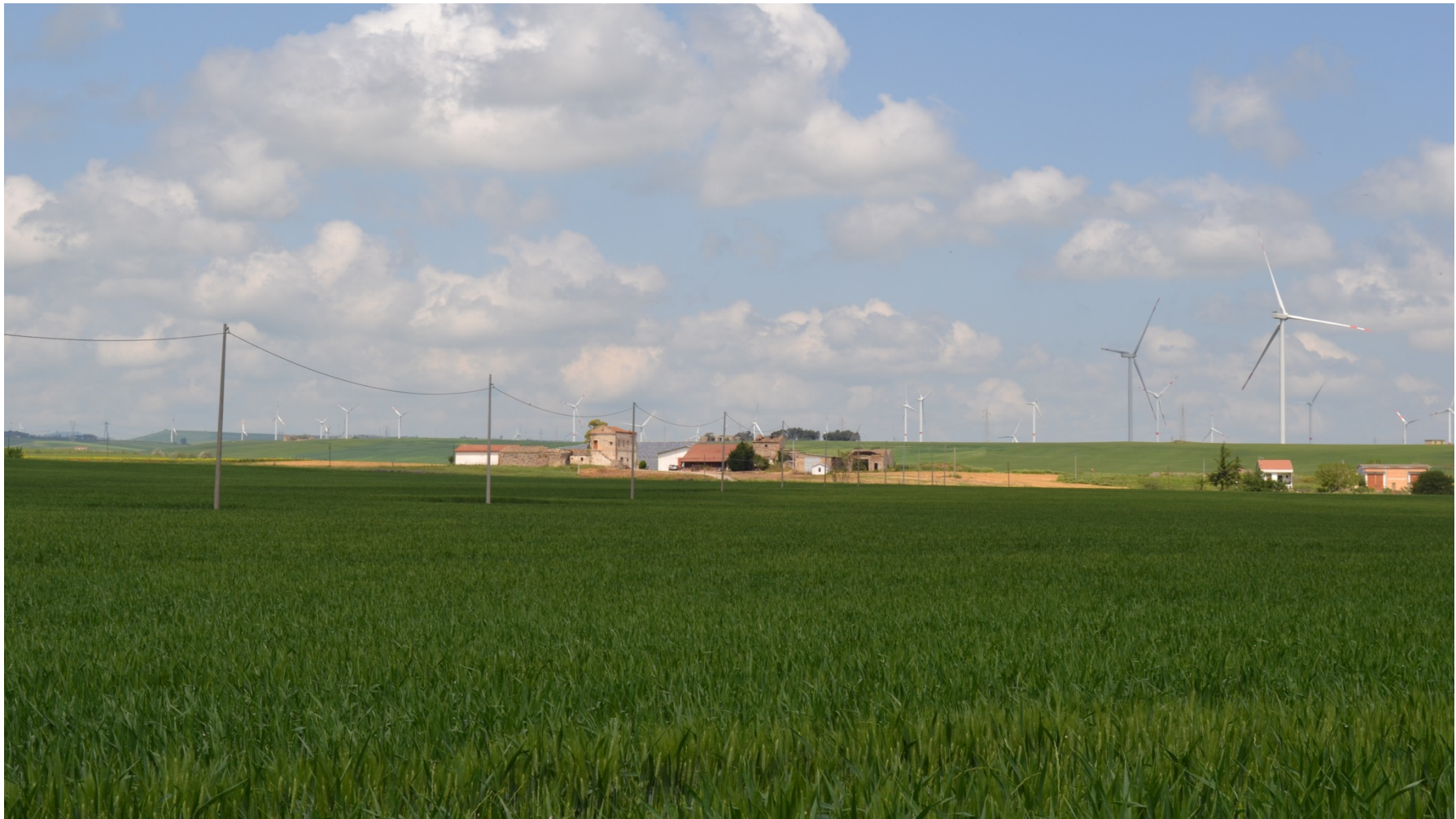
Fotoinserimento da punto n. 09 del Trattarello – Foto post-operam (impianto visibile)
