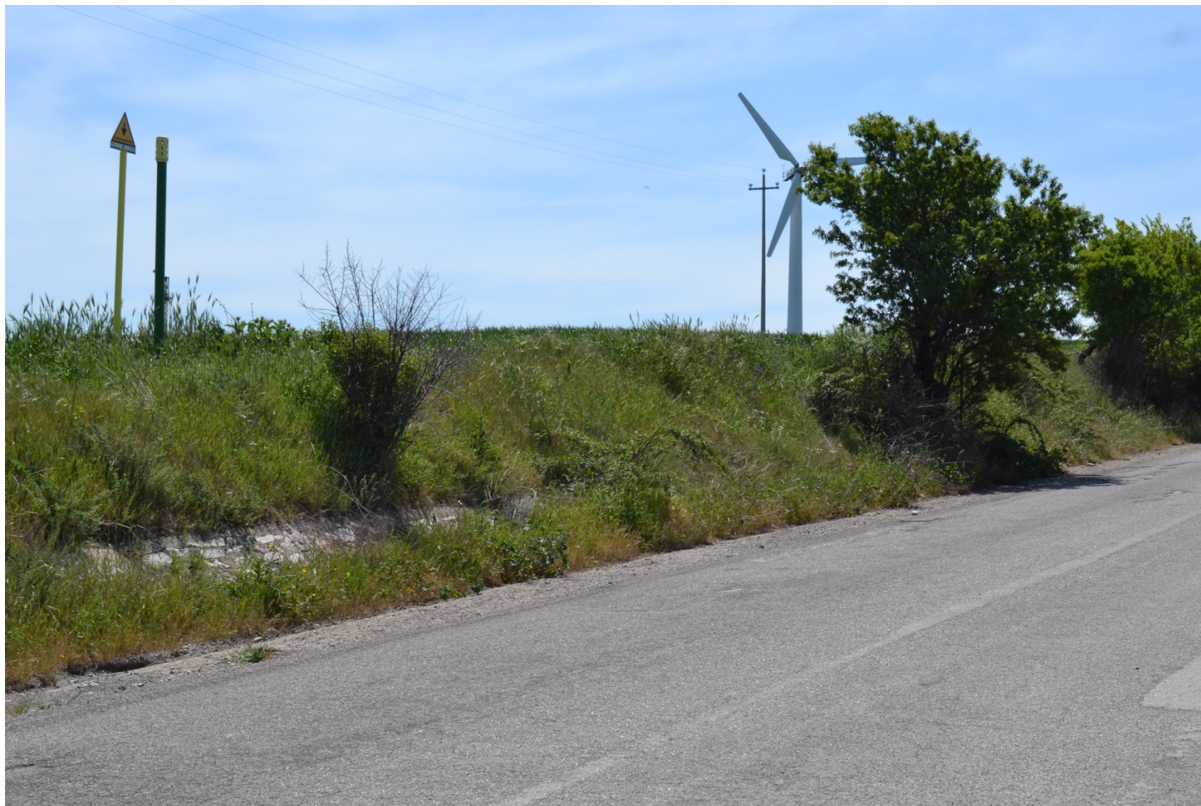
Ripresa fotografica da punto n. 4-SP 102 – Impianto non visibile
