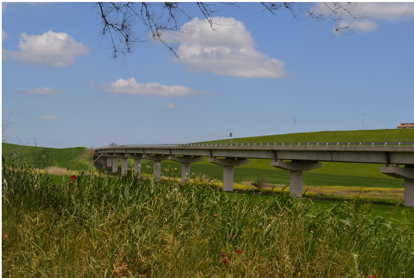
Ripresa fotografica da punto n. 2-SP 102 – Impianto non visibile
