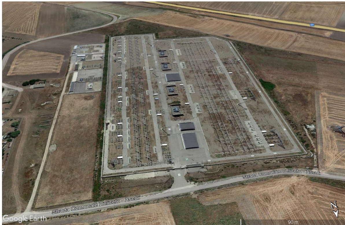
Il cavo AT sarà posato in corrispondenza della strada non asfaltata (sulla destra nell'immagine dall'alto di GE
