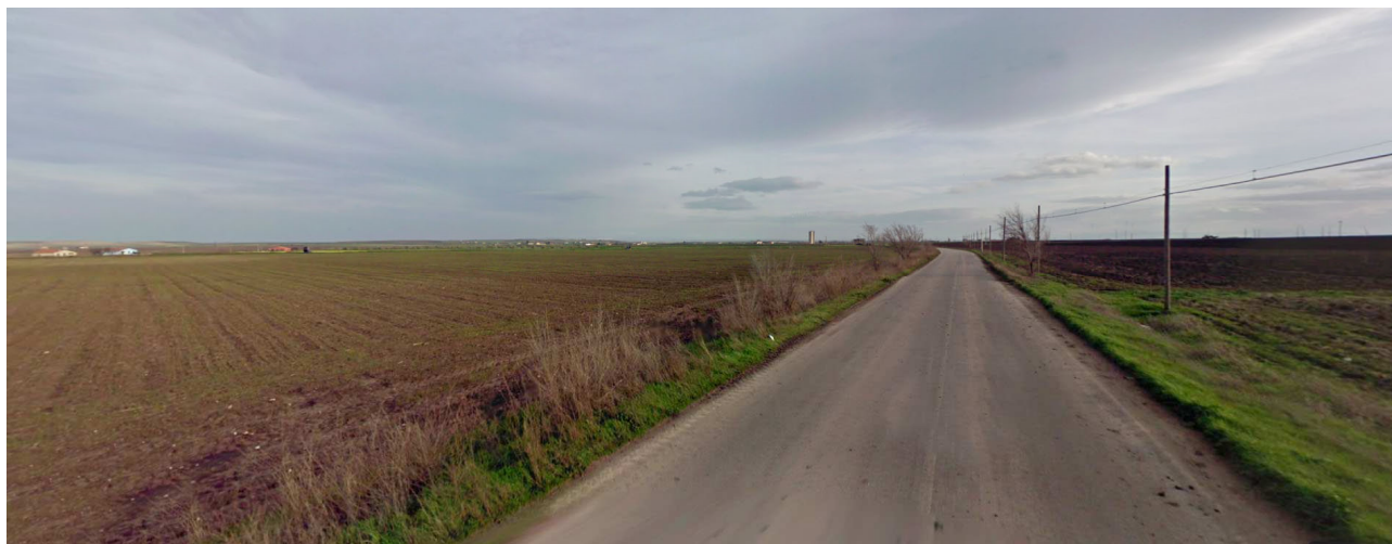
Figura 6. Coni visivi lungo la SP89. Visuale verso est
