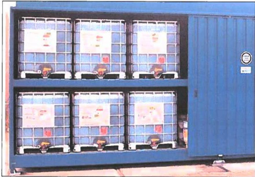
Figura 17. Sistemi di stoccaggio delle sostanze pericolose in container
