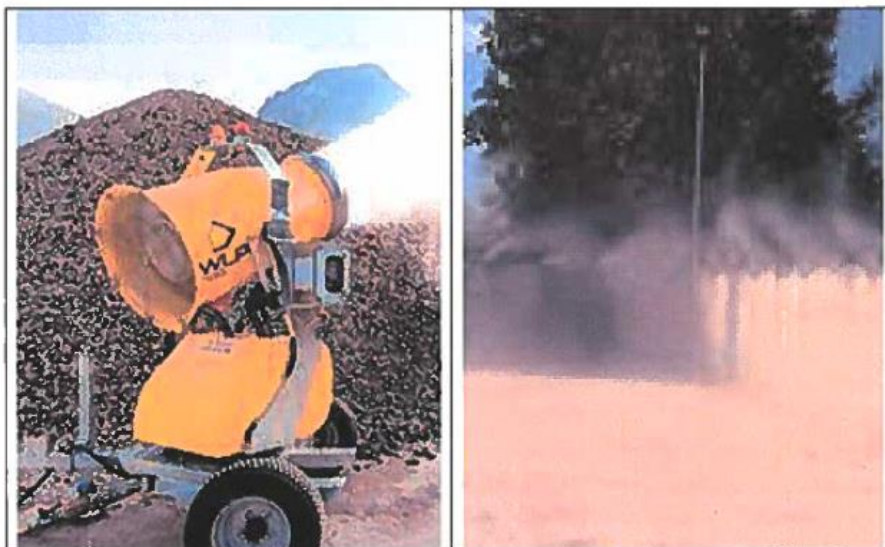
Figura 21. Sistemi di bagnatura delle aree di cantiere e depositi: cannoni (sx), nebulizzatori (dx).
