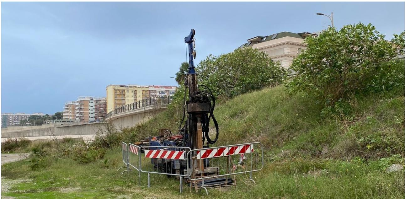
**Figura 3.2-3.** Sonda perforatrice posizionata su un punto di sondaggio.
