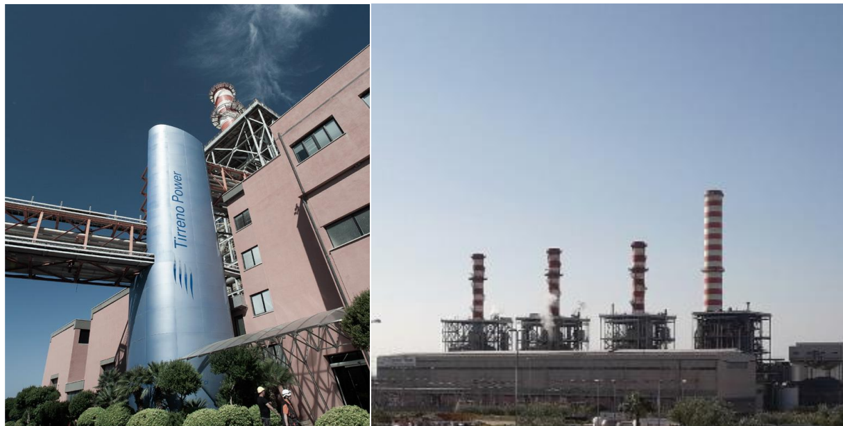
Figura 2 Centrale di Torrevaldaliga Sud
