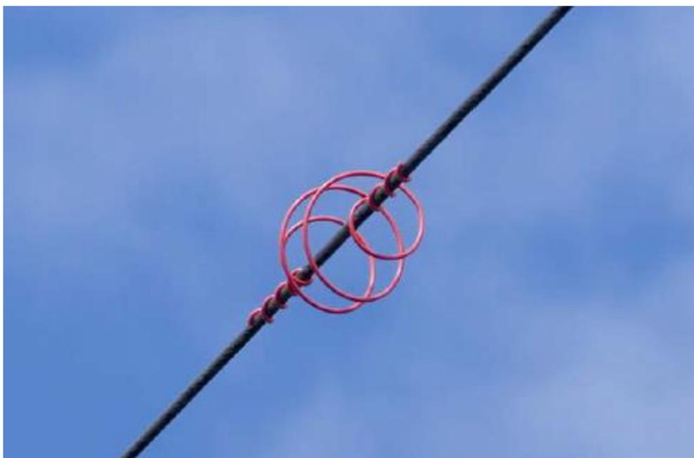
**Figura 4-1:** Spirale colorata in plastica per la segnalazione dei cavi.
