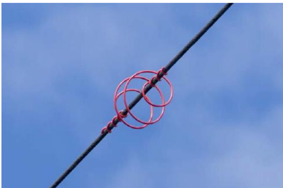
Figura 1: Spirale colorata in plastica per la segnalazione dei cavi
