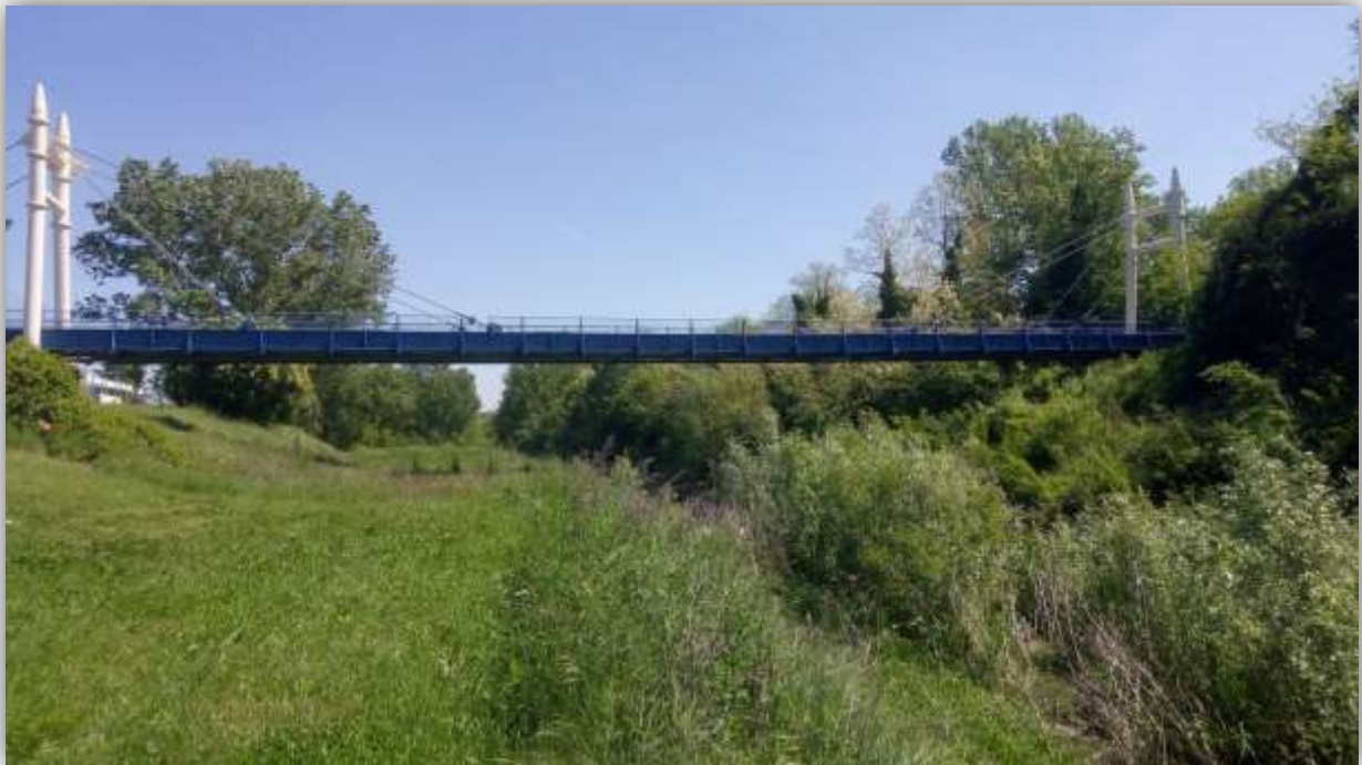
Figura 2-6: Ponte ciclopeonale sull'Idice nei pressi del campo sportivo di Castenaso.
