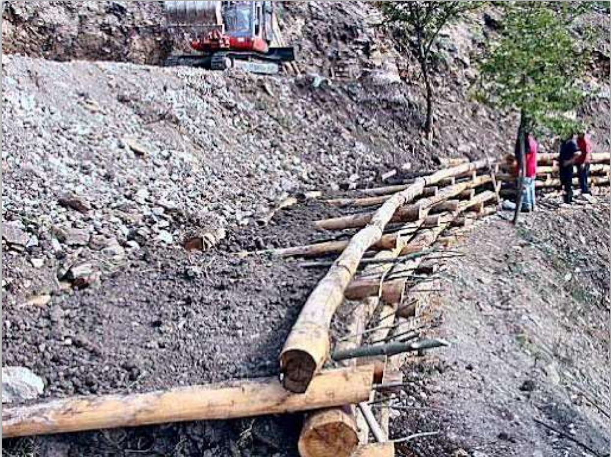
Figura 4-11: Palificata viva a doppia parete in corso di realizzazione.
