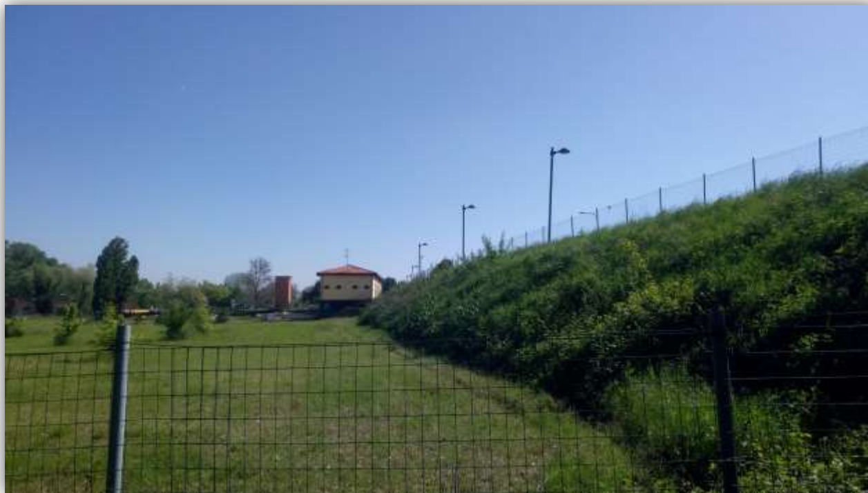
Figura 2-19: Scarpata inerbita tra via Fiesso e l'area in corso di bonifica.
