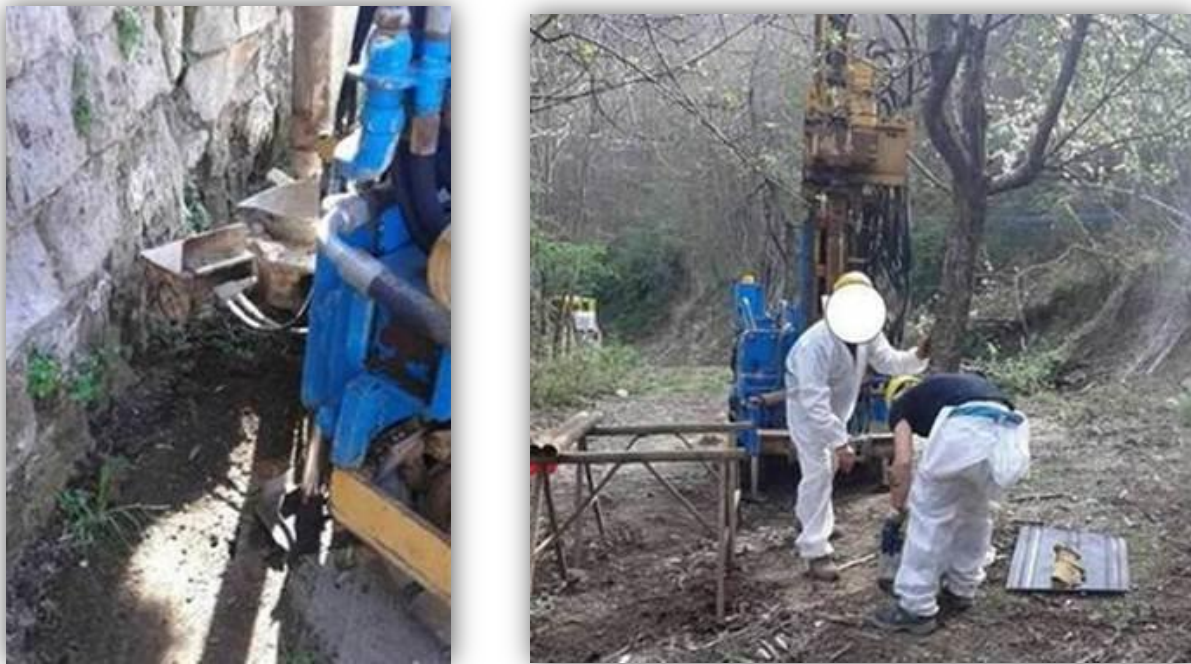
Figura 7-1: Sondaggio effettuato mediante perforazione a carotaggio.
