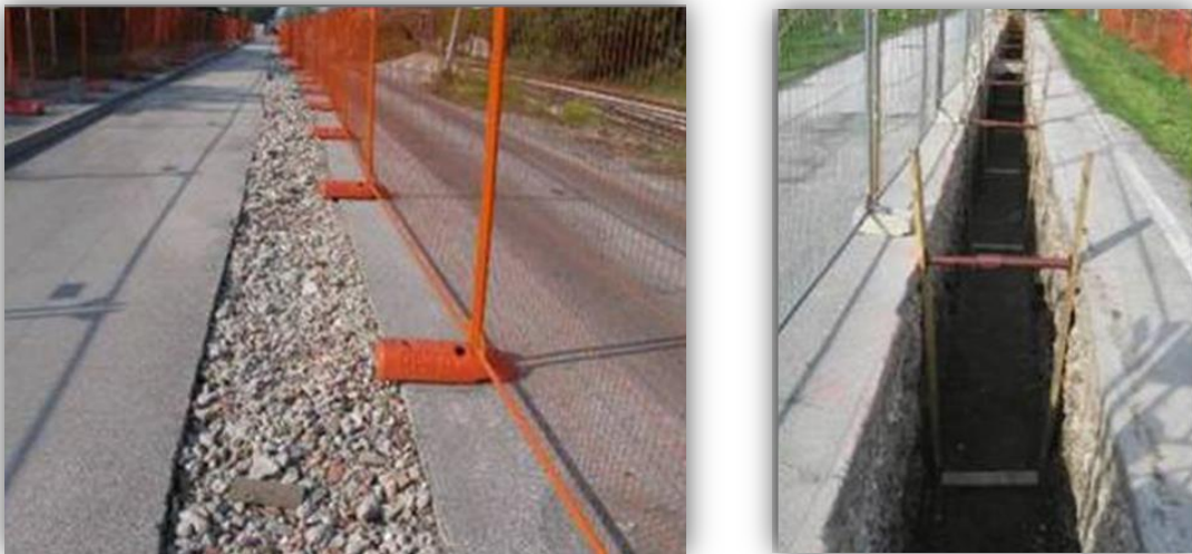
Figura 4-5: Taglio dell'asfaltatura e scavo aperto.
