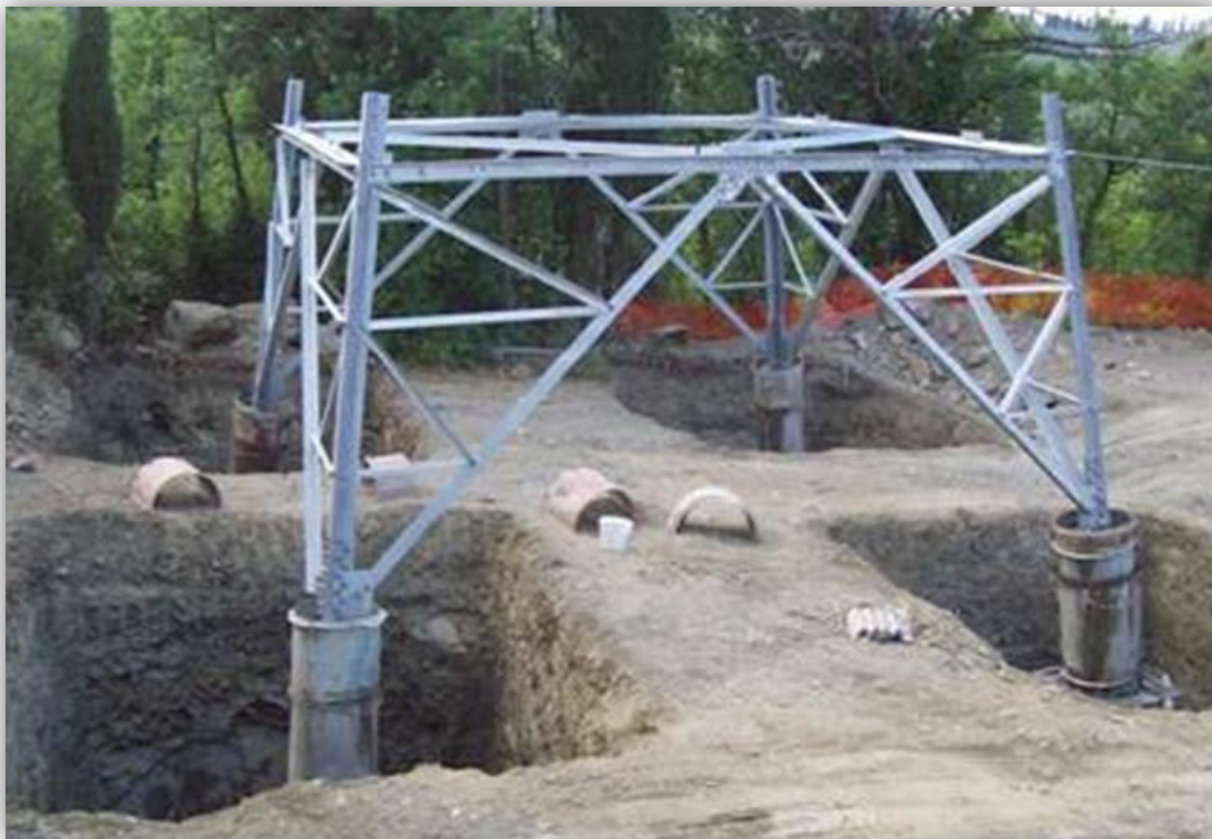
Figura 4-4: Esempio di fondazione di un sostegno.
