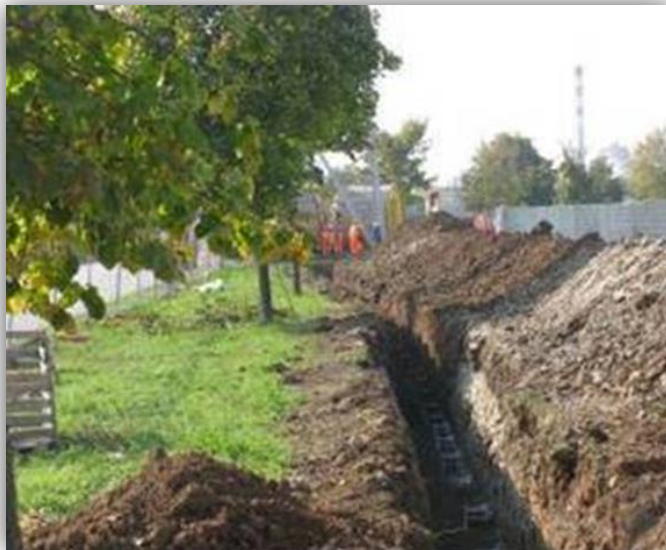
Figura 4-6: Esempio di trincee di scavo per la posa dei cavi interrati e il deposito temporaneo del materiale da scavo.
