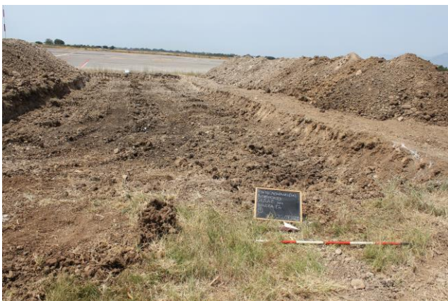
Fig.14 Nord airside. Trincea12: Panoramica scavo eseguito, vista da nord.
