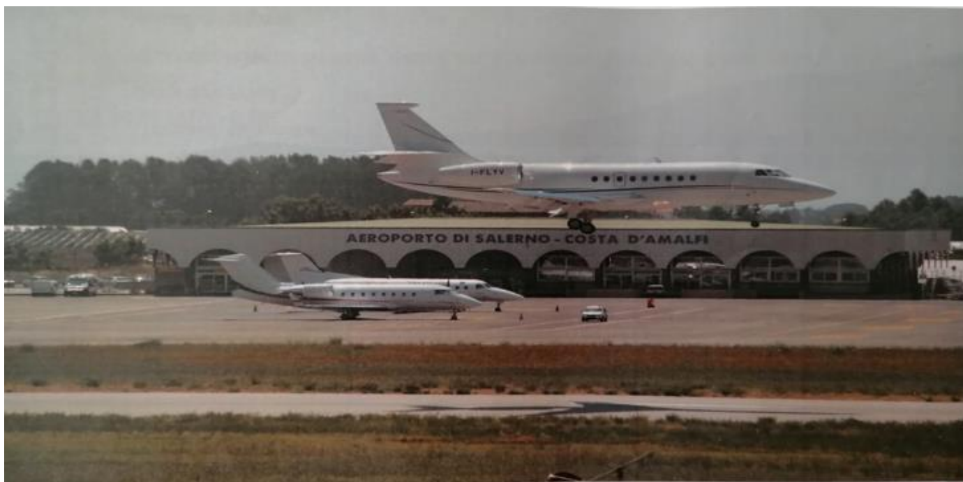
Fig. 4 Panoramica aeroporto Salerno “Costa d’Amalfi”, vista da ovest
