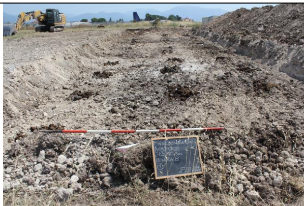
Fig.17 Nord airside. Trincea 10: Panoramica scavo eseguito, vista da nord.
