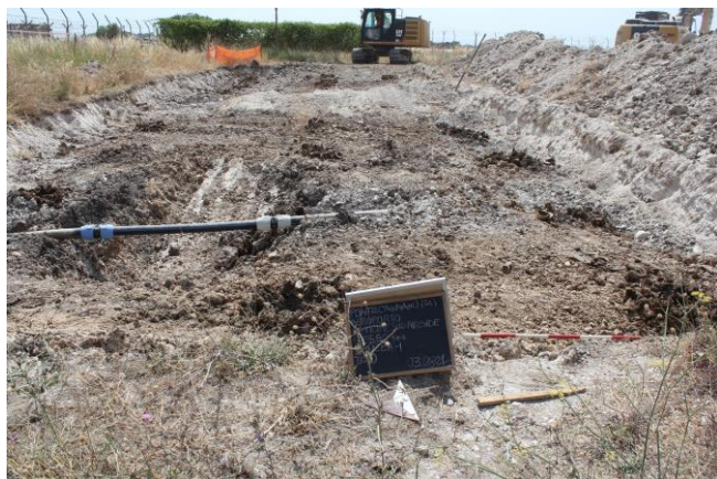
Fig.28 Sud airside. Trincea 1: Panoramica scavo, vista da nord.
