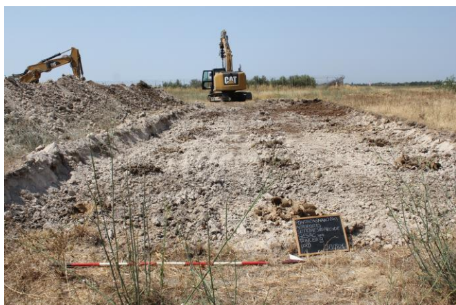
Fig.36 Sud airside. Trincea 9: Panoramica scavo, vista da nord.
