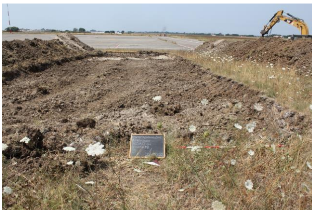
Fig.24 Nord airside. Trincea 19: Panoramica scavo, vista da nord.
