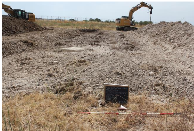
Fig.35 Sud airside. Trincea 8: Panoramica scavo, vista da nord.
