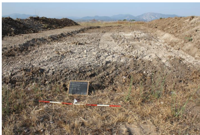
Fig.25 Nord airside. Trincea 20: Panoramica scavo, vista da nord.
