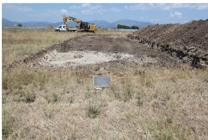
Fig.20 Nord airside. Trincea 15: Panoramica scavo, vista da nord.
