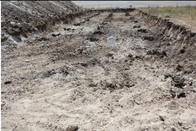
Fig.10 Nord airside. Trincea 9: Panoramica scavo eseguito, vista da nord.
