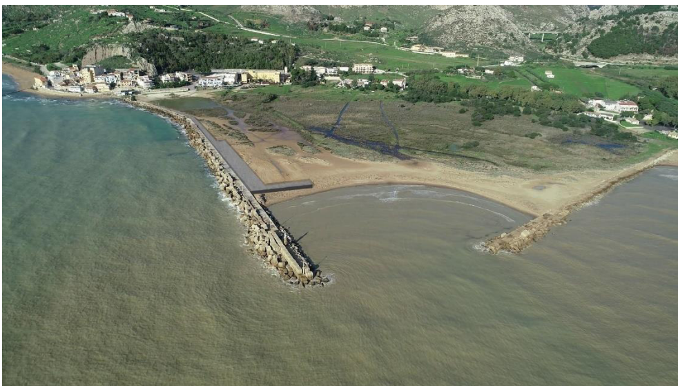
Figura 63: Vista da punto in quota, da sud-ovest. Dall'alto in basso: Stato di fatto, Fine lavori, Fine Dragaggio.
