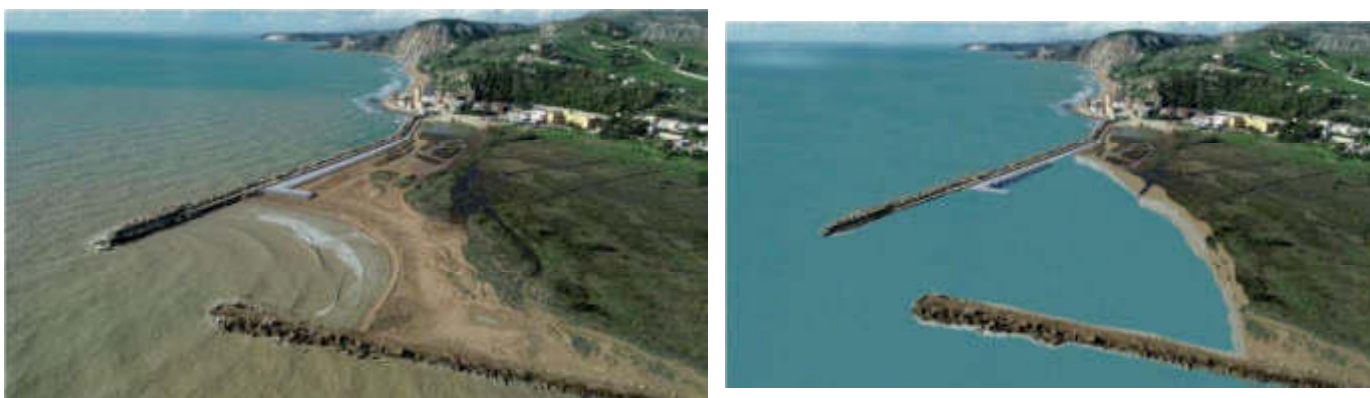
Figura 4 – Nuova banchina prima e dopo il prelievo dei sedimenti
