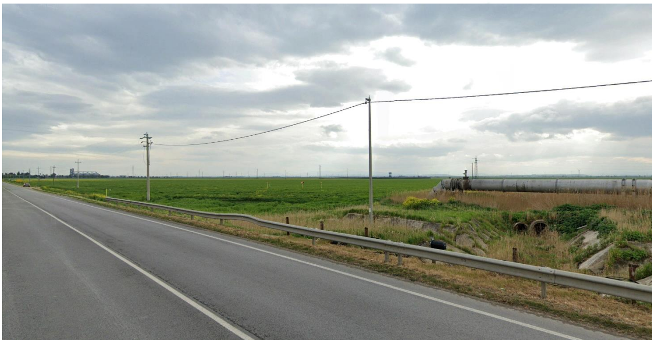
Esempio di fotoinserimento con opere di mascheratura vegetale nel punto di osservazione A
