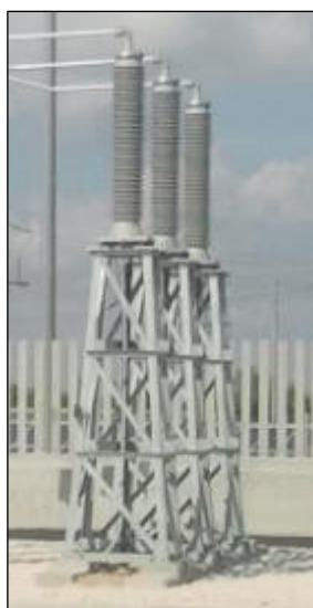
Fig. 11. Terminale cavo AT tipo.
