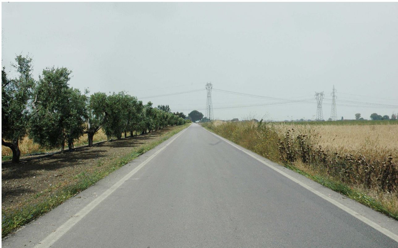
Fig. 30. Intervento di piantumazione lungo la recinzione
