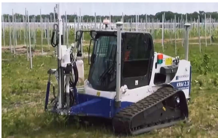
Fig. 11. Esempio di fissaggio delle strutture di supporto
