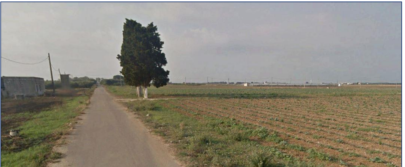
Figura 3-1: Strada Provinciale SP82 in prossimità dell'impianto
