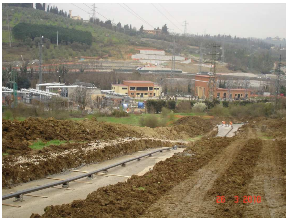
Figura 3-15: Esempio di realizzazione di elettrodotto in cavo interrato a 380kV in area agricola (Regione Toscana)
