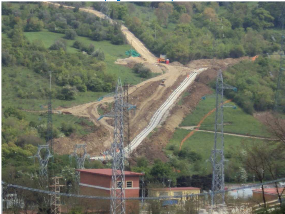
Figura 3-14:-Esempio di realizzazione di elettrodotto in cavo interrato a 380kV in area boscata (Regione Toscana)
