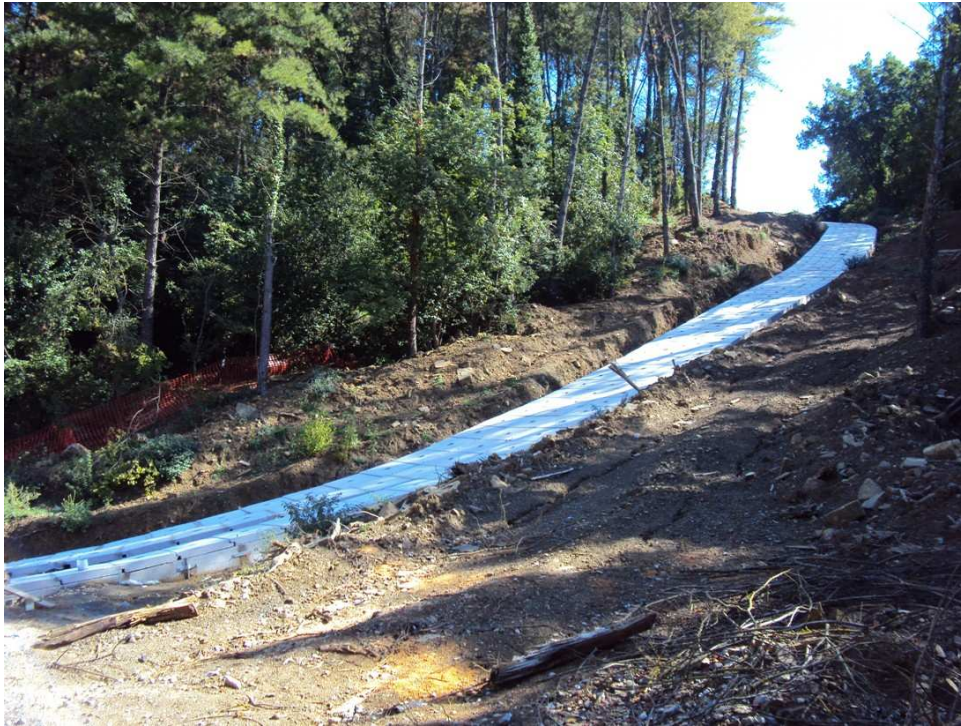
Figura 3-14:-Esempio di realizzazione di elettrodotto in cavo interrato a 380kV in area boscata (Regione Toscana)
