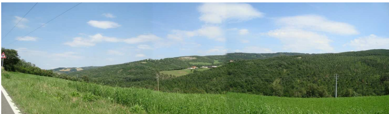
Figura 4-77: Tratto in corrispondenza del traliccio 85 - 86
