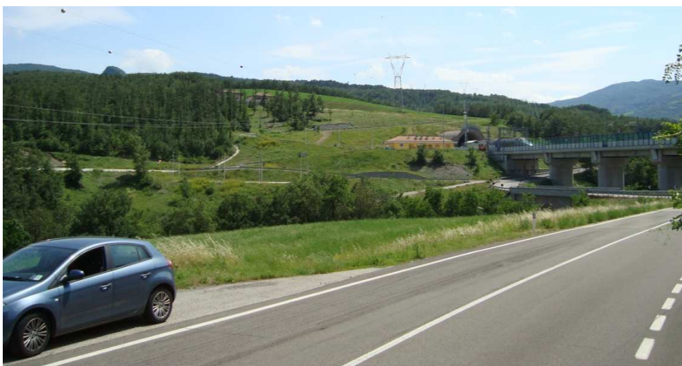
Figura 4-78: Tratto in corrispondenza del traliccio 87 - 88. In primo piano la linea da smantellare
