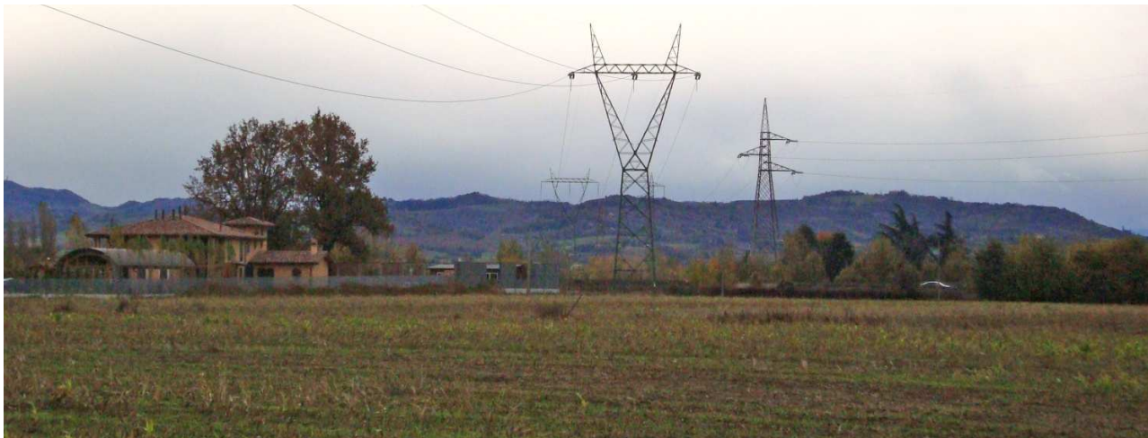
Figura 4-70 – vista della pianura agricola ai piedi delle colline dove è visibile anche l'esistente linea che verrà demolita (sulla sinistra)
