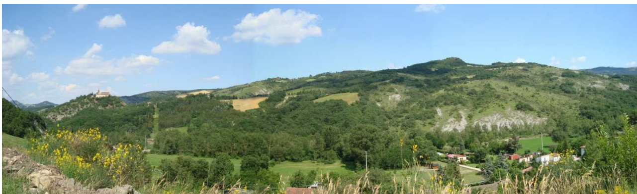
Figura 4-75: Tratto in corrispondenza dei tralicci 72 e 73
