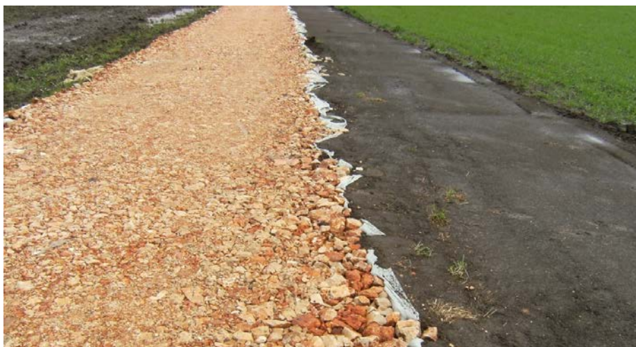
Dettaglio pacchetto stradale con geotessuto
