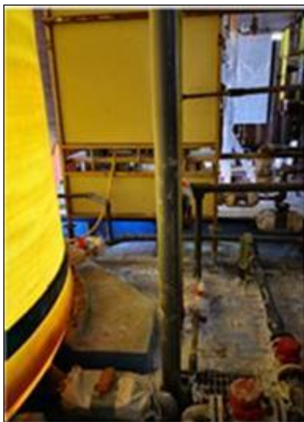
Foto 7 – Serbatoio di NaOH, tubazione di sfiato prima dell'innesto del bocchello
