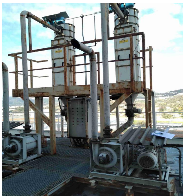
Foto 14 – Estrattori bunker carbone, vista dei ventilatori e del tubo di sfiato in uscita (in primo piano)
