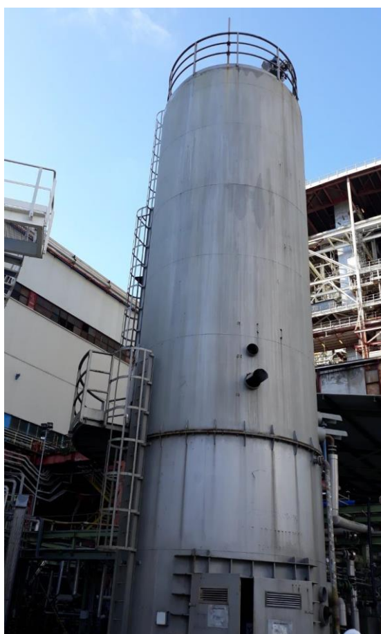
Foto 13 – Serbatoio carbonato di sodio, vista complessiva
