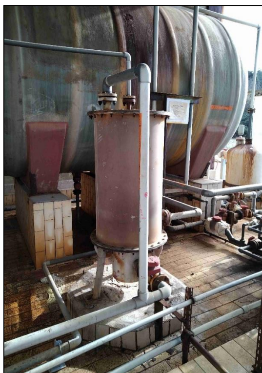
Foto 1 – Serbatoio di HCl, tubazione di sfiato della guardia idraulica prima dell'innesto del bocchello
