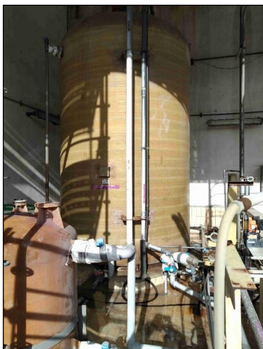
Foto 3 – Serbatoio di NaClO, tubazione di sfiato prima dell'innesco del bocchello
