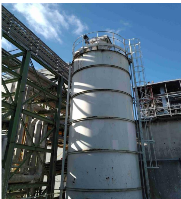
Foto 11 – Serbatoio di \text{Ca(OH)}_2 , vista complessiva
