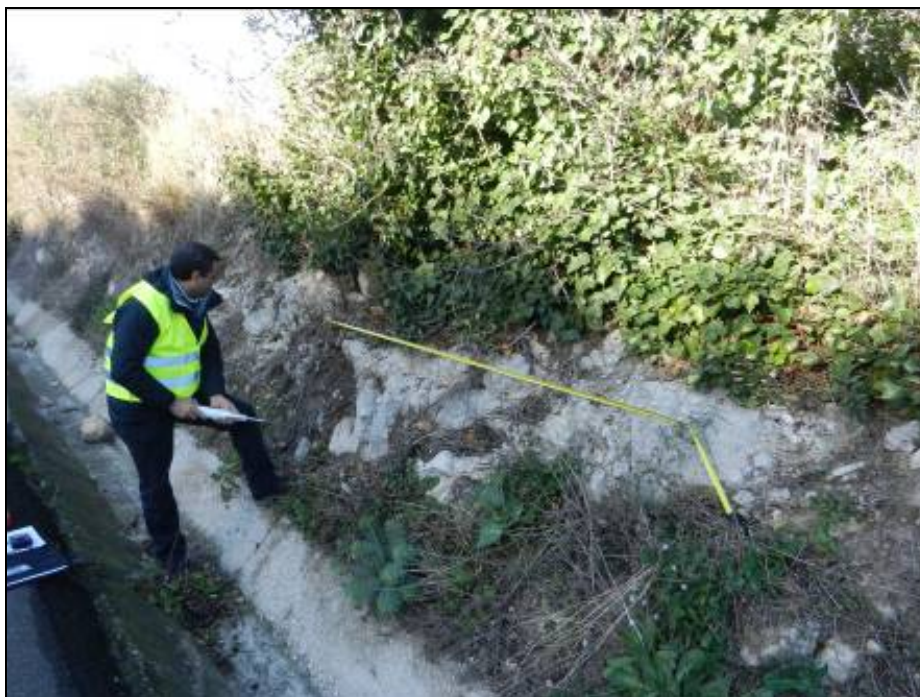
Figura A-4 Stazione geomeccanica SG4
