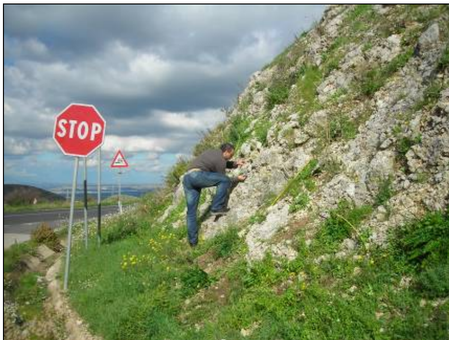
Figura A-2 Stazione geomeccanica SG2
