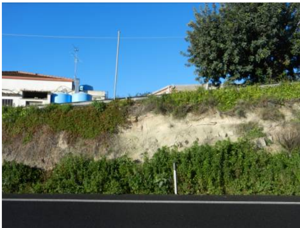
Figura A-2 Stazione geomeccanica SG43
