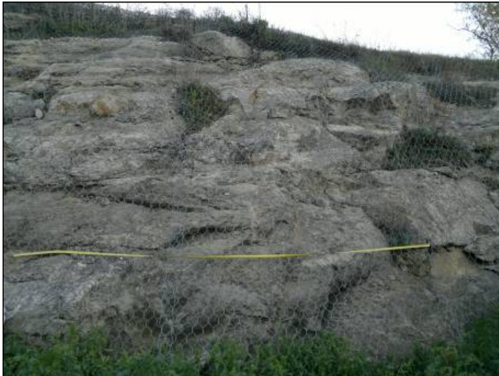
Figura A-1 Stazione geomeccanica SG10
