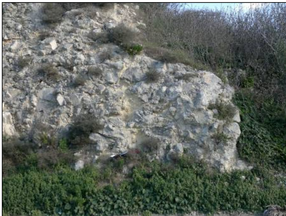
Figura A-6 Stazione geomeccanica SG6
