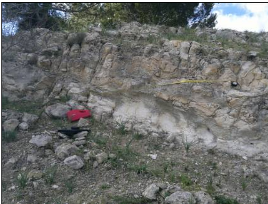
Figura A-8 Stazione geomeccanica SG8
