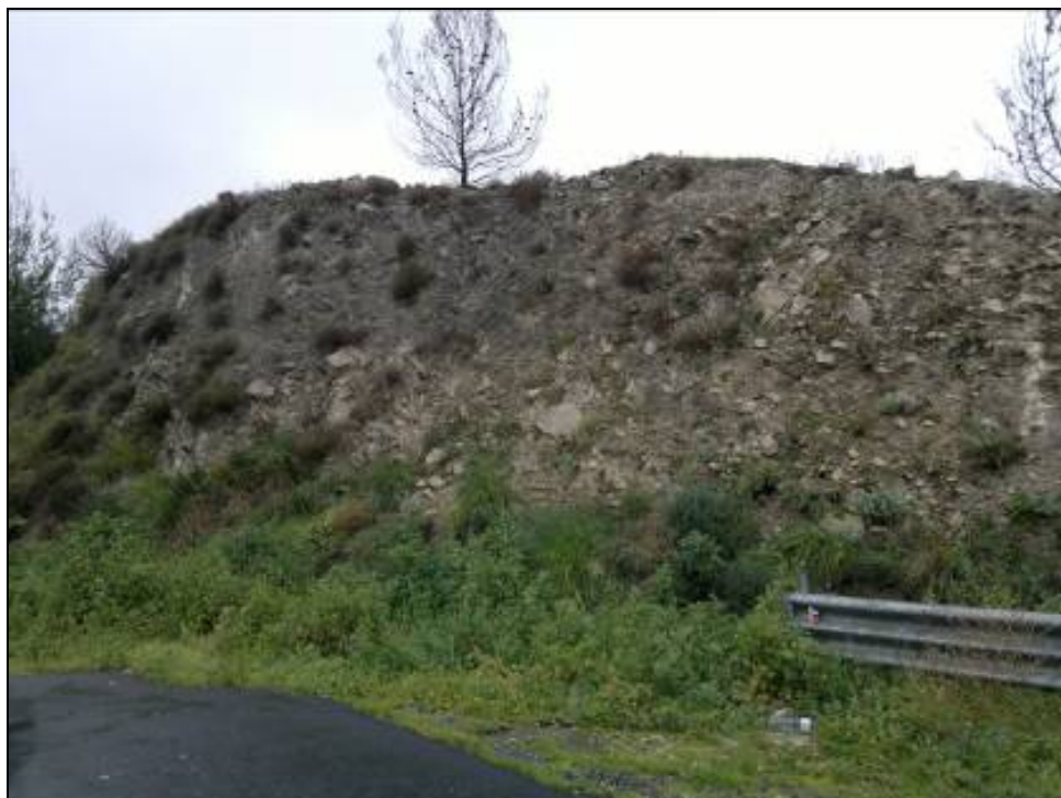
Figura A-13 Stazione geomeccanica SG41
