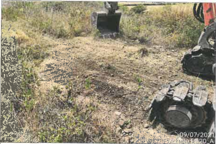
Ubicazione pozzetto esplorativo
