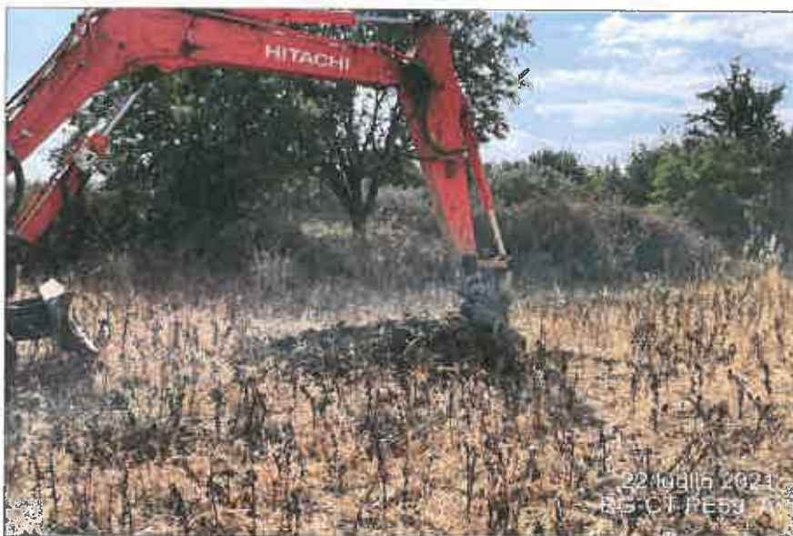
Ubicazione pozzetto esplorativo
