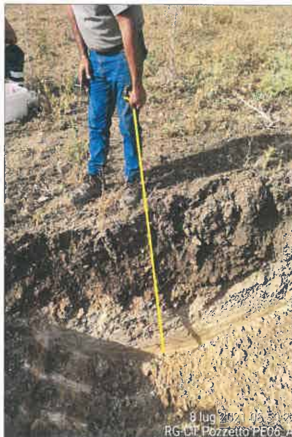
Pozzetto esplorativo - profondità da m 0,00 a m 1,00
