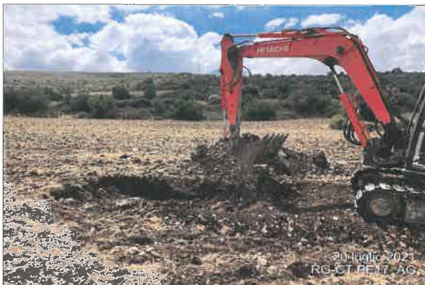
Ubicazione pozzetto esplorativo
