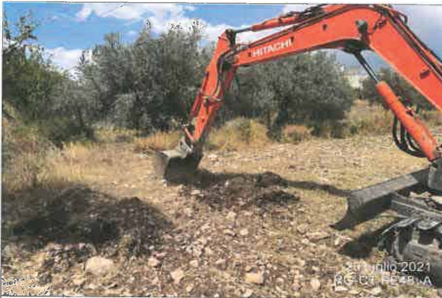
Ubicazione pozzetto esplorativo
