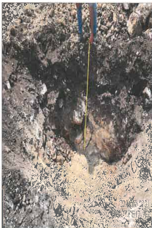
Pozzetto esplorativo - profondità da m 0,00 a m 2,00
