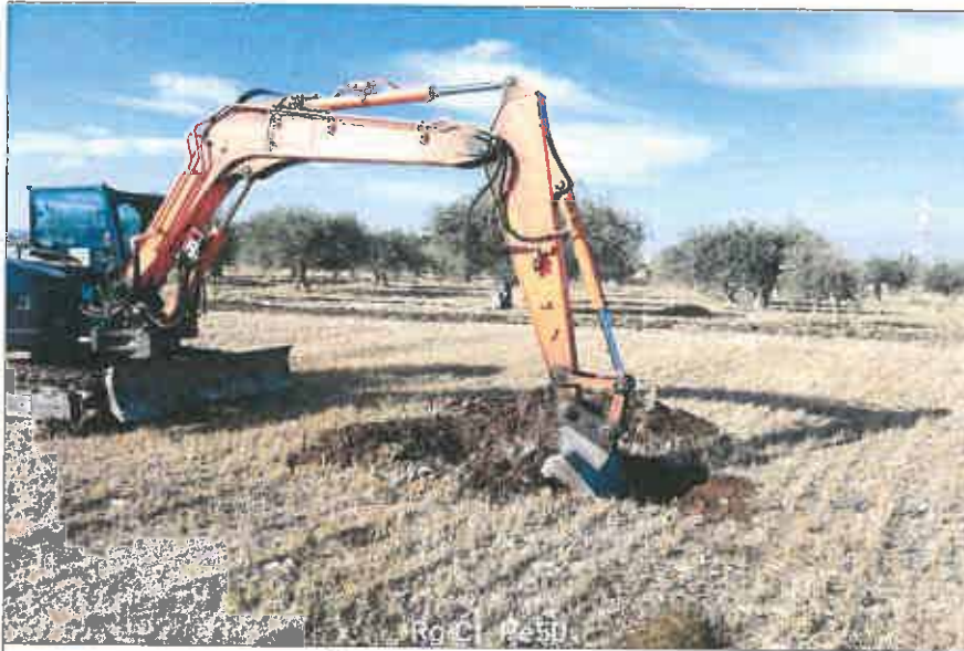
Ubicazione pozzetto esplorativo
