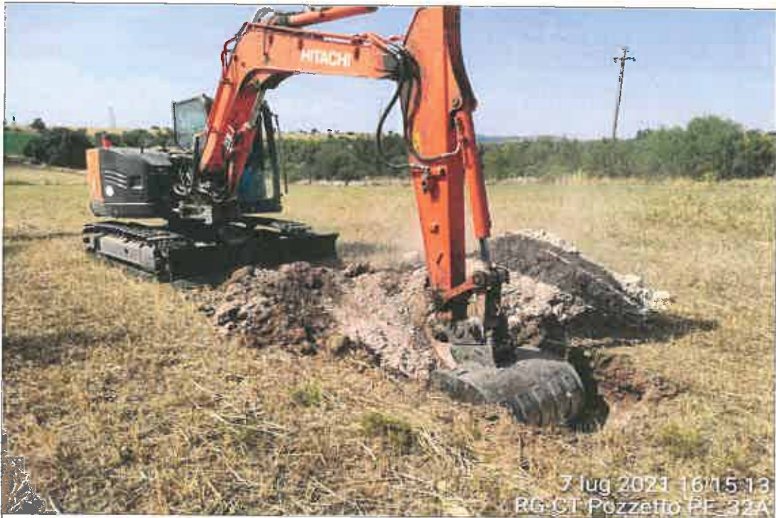
Ubicazione pozzetto esplorativo
