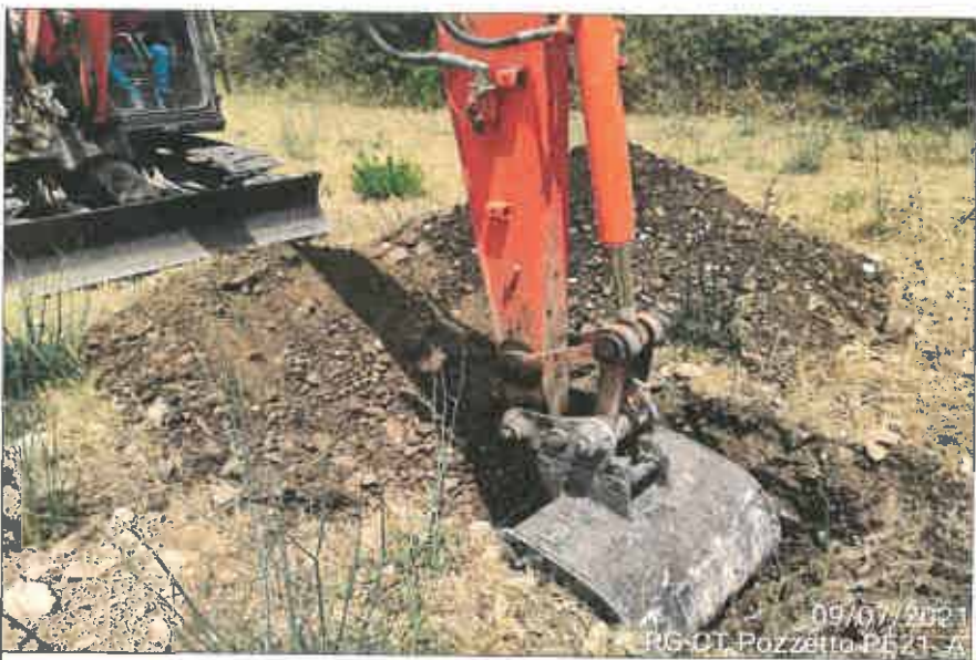
Ubicazione pozzetto esplorativo
