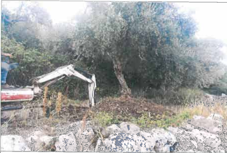
Ubicazione pozzetto esplorativo
