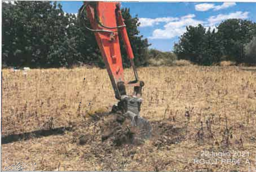
Ubicazione pozzetto esplorativo
