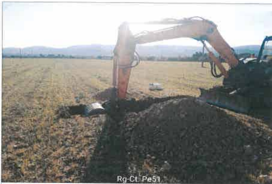
Ubicazione pozzetto esplorativo
