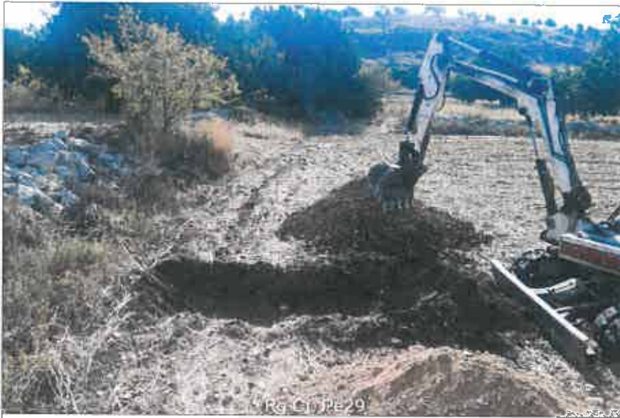
Ubicazione pozzetto esplorativo
