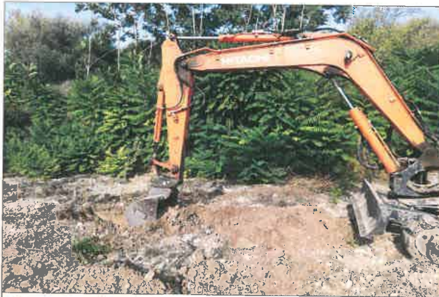
Ubicazione pozzetto esplorativo
