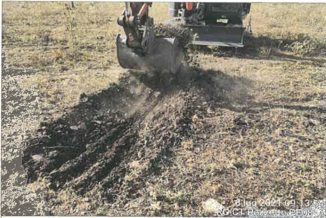
Ubicazione pozzetto esplorativo
