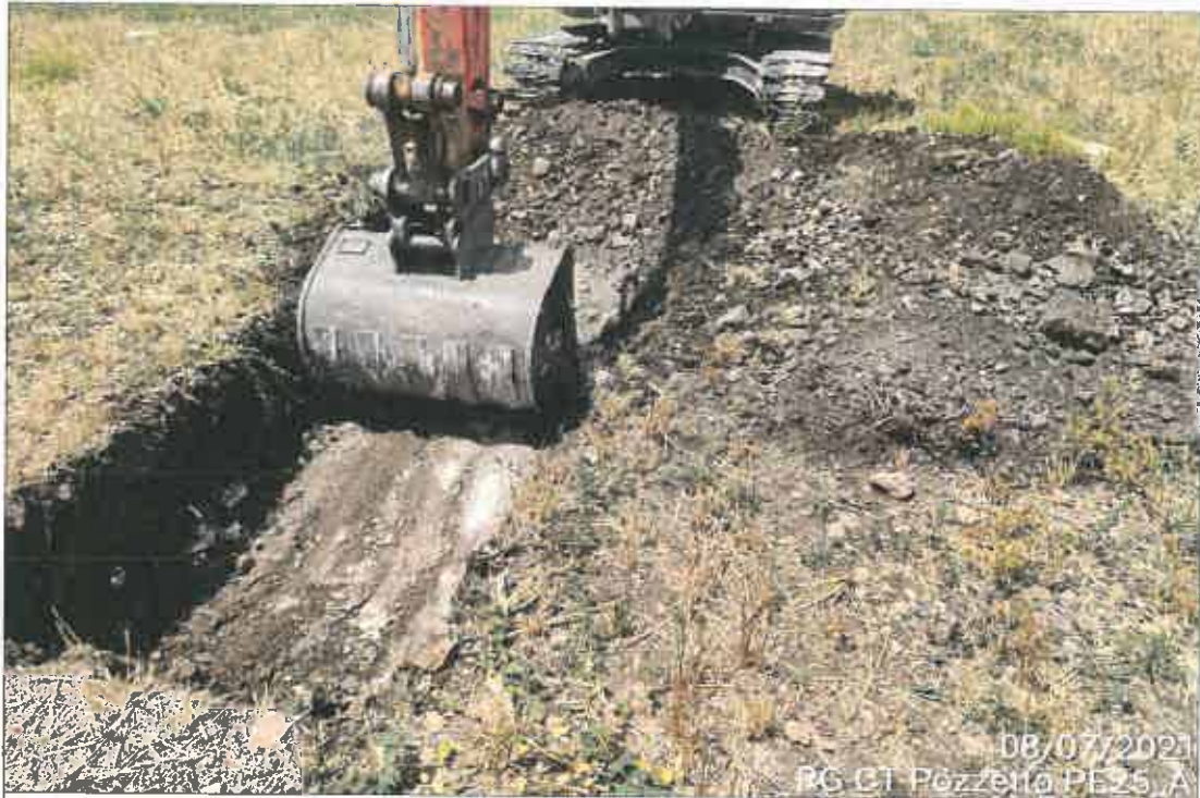
Ubicazione pozzetto esplorativo
