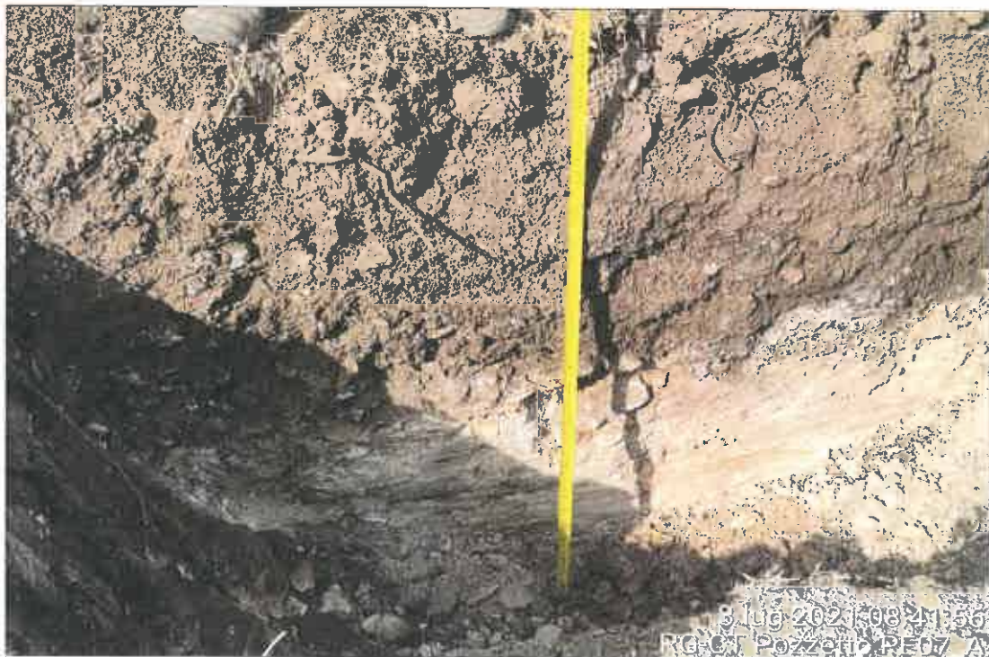
Pozzetto esplorativo - profondità da m 0,00 a m 1,00
