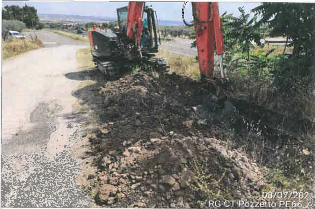
Ubicazione pozzetto esplorativo
