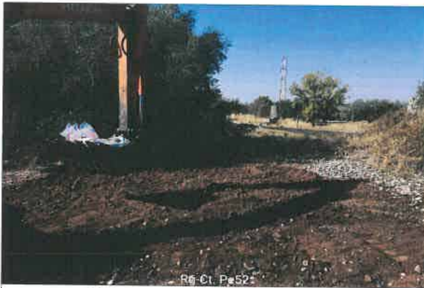
Ubicazione pozzetto esplorativo
