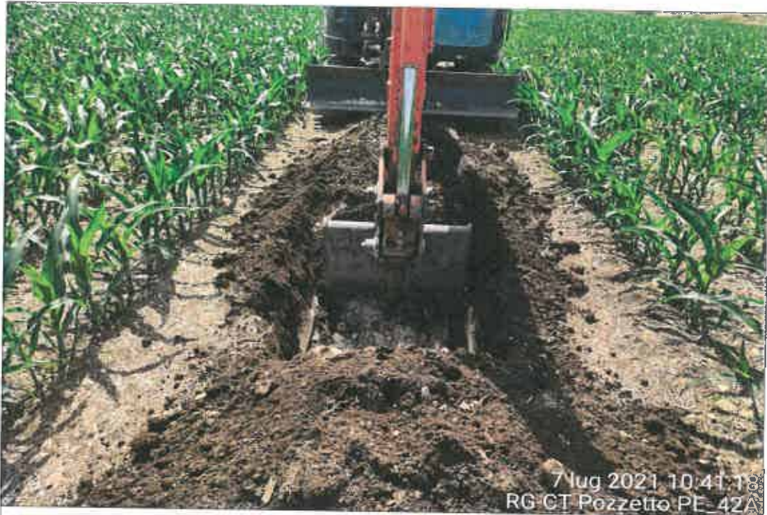
Ubicazione pozzetto esplorativo
