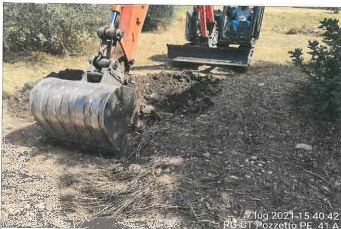
Ubicazione pozzetto esplorativo
