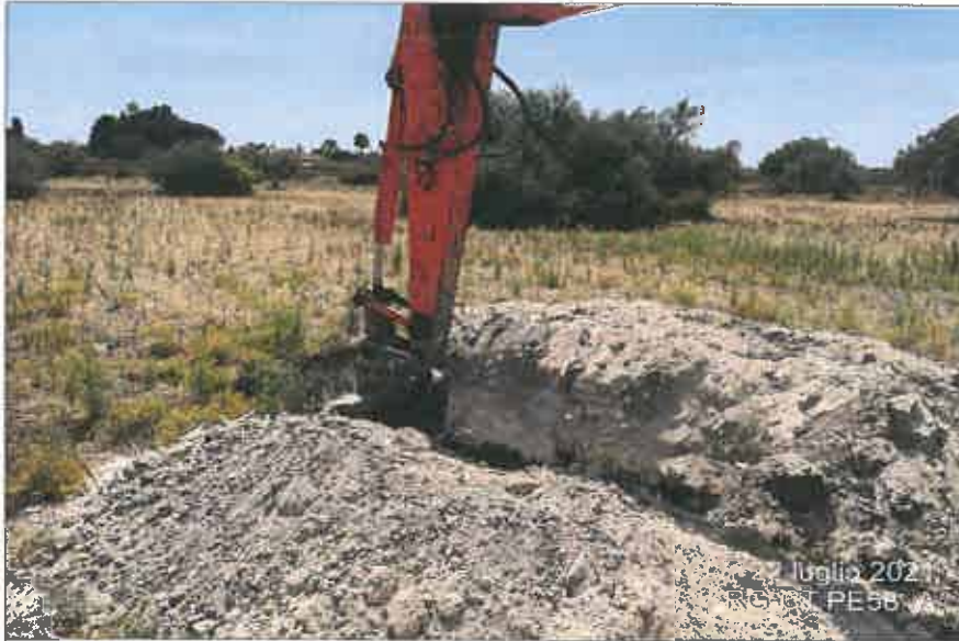
Ubicazione pozzetto esplorativo
