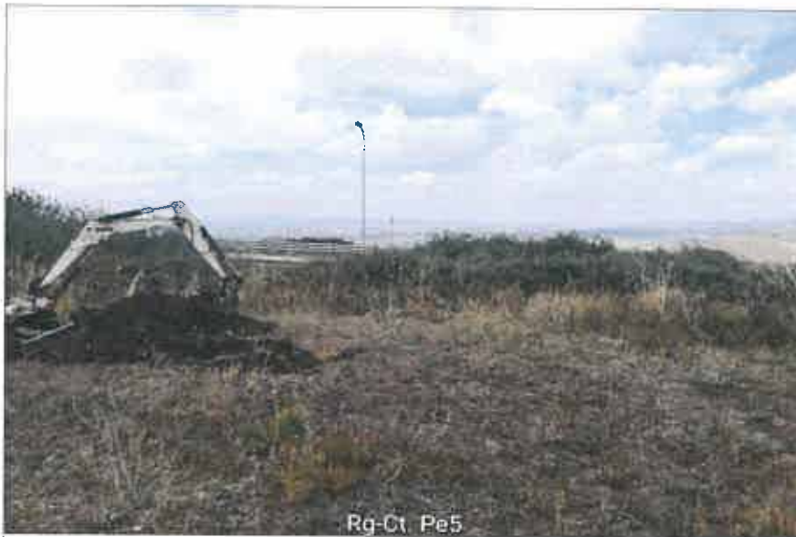
Ubicazione pozzetto esplorativo
