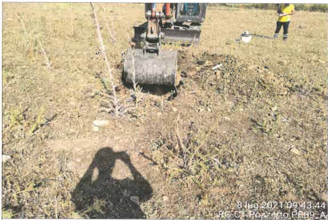
Ubicazione pozzetto esplorativo
