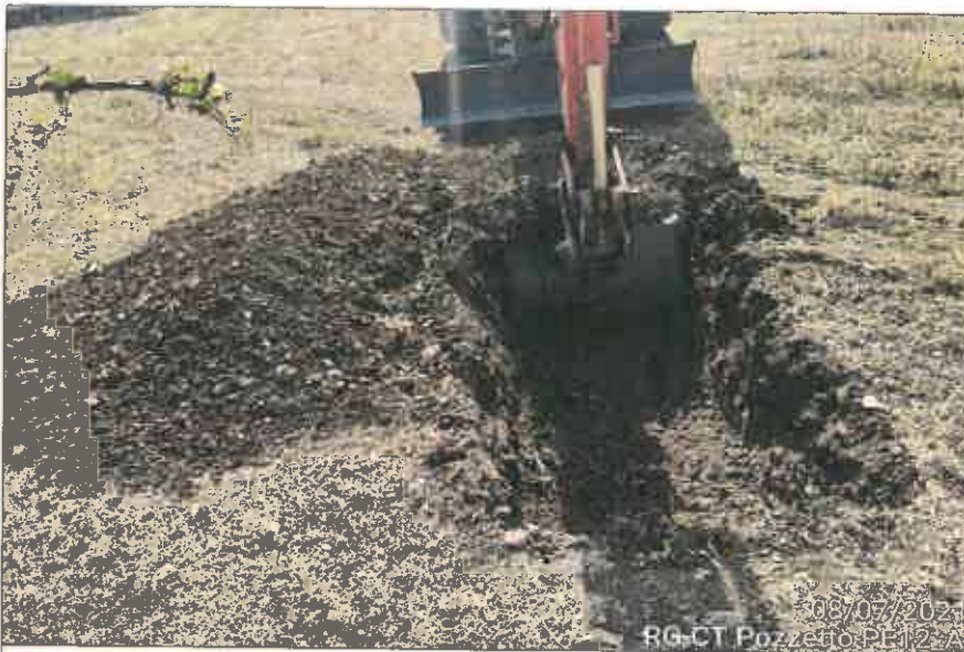
Ubicazione pozzetto esplorativo
