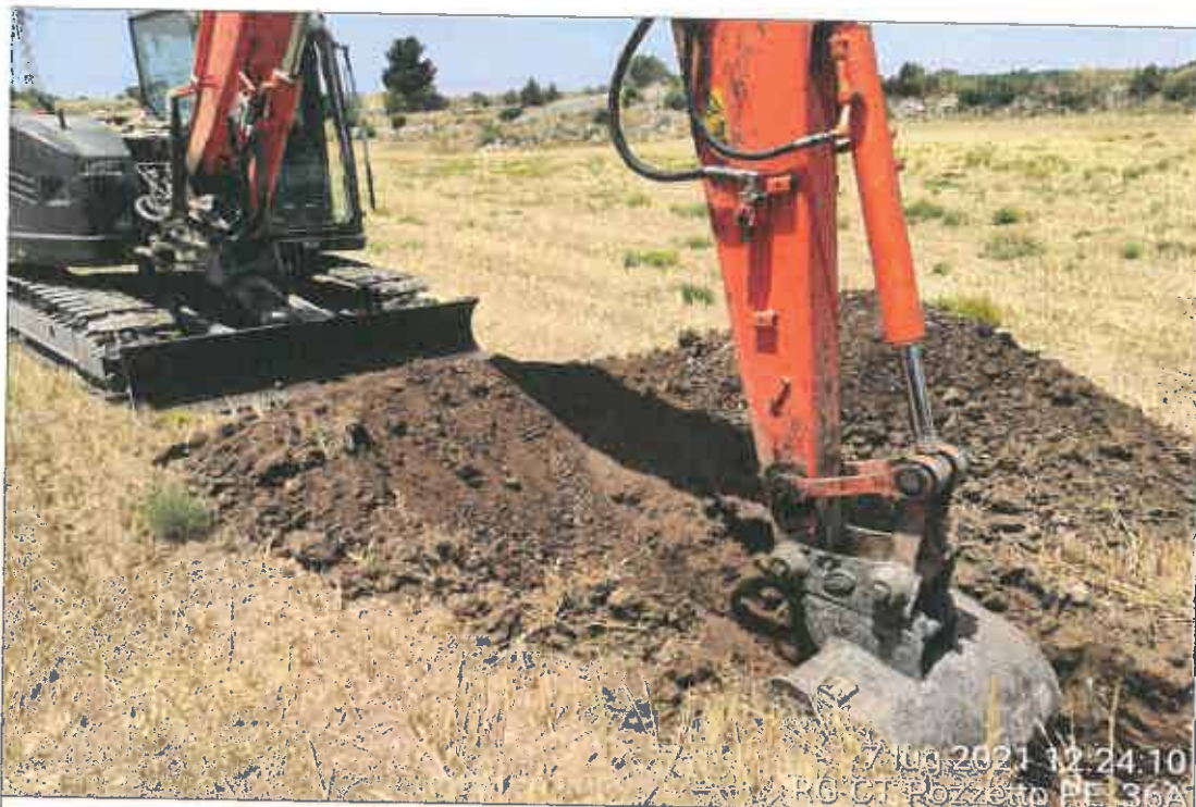
Ubicazione pozzetto esplorativo
