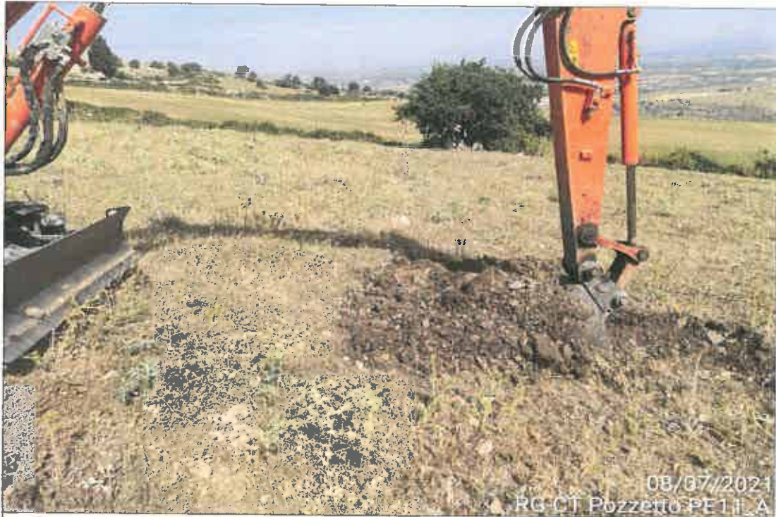
Ubicazione pozzetto esplorativo
