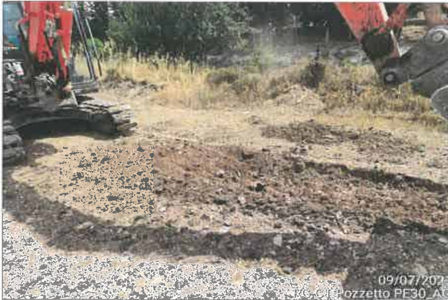
Ubicazione pozzetto esplorativo
