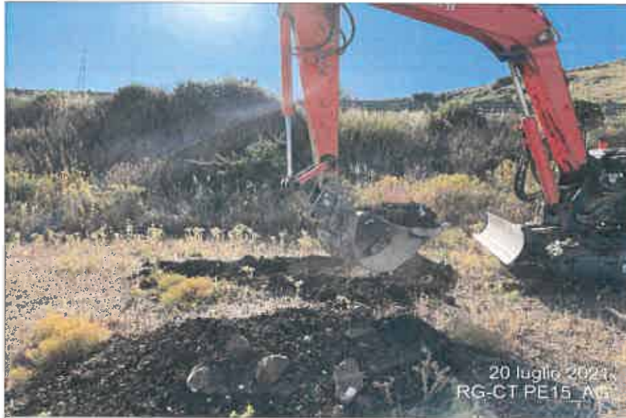
Ubicazione pozzetto esplorativo
