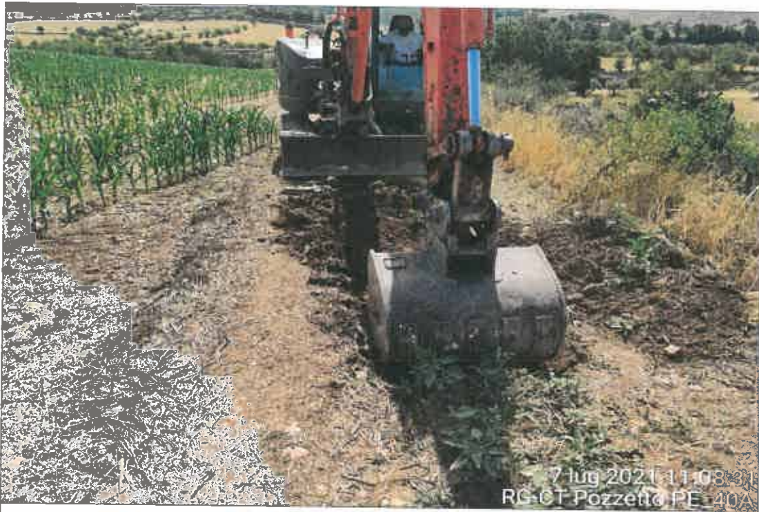
Ubicazione pozzetto esplorativo
