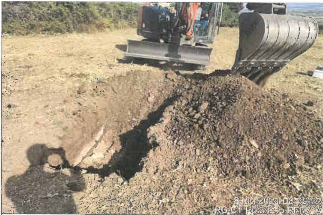
Ubicazione pozzetto esplorativo
