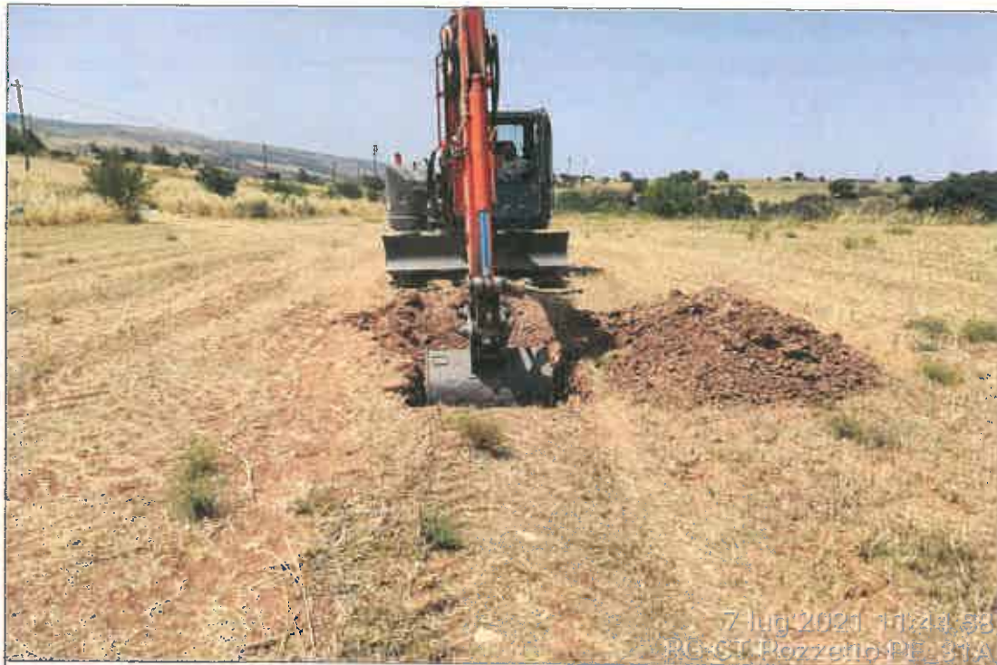
Ubicazione pozzetto esplorativo
