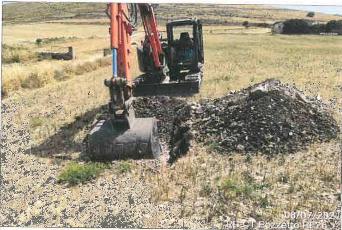
Ubicazione pozzetto esplorativo
