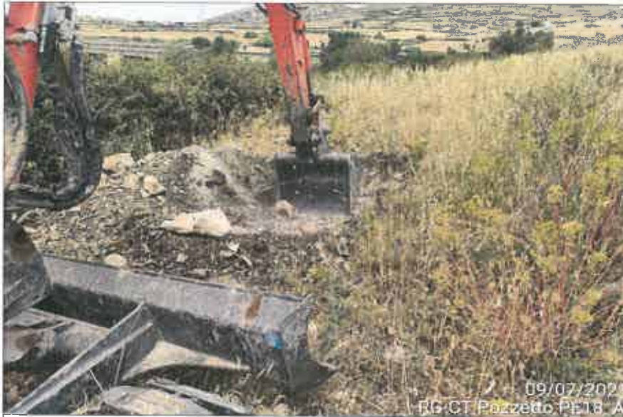
Ubicazione pozzetto esplorativo
