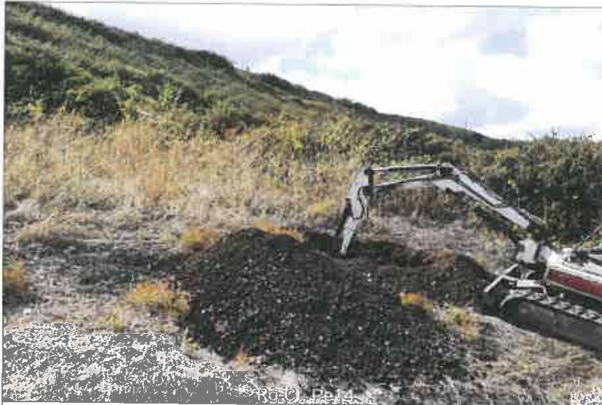
Ubicazione pozzetto esplorativo
