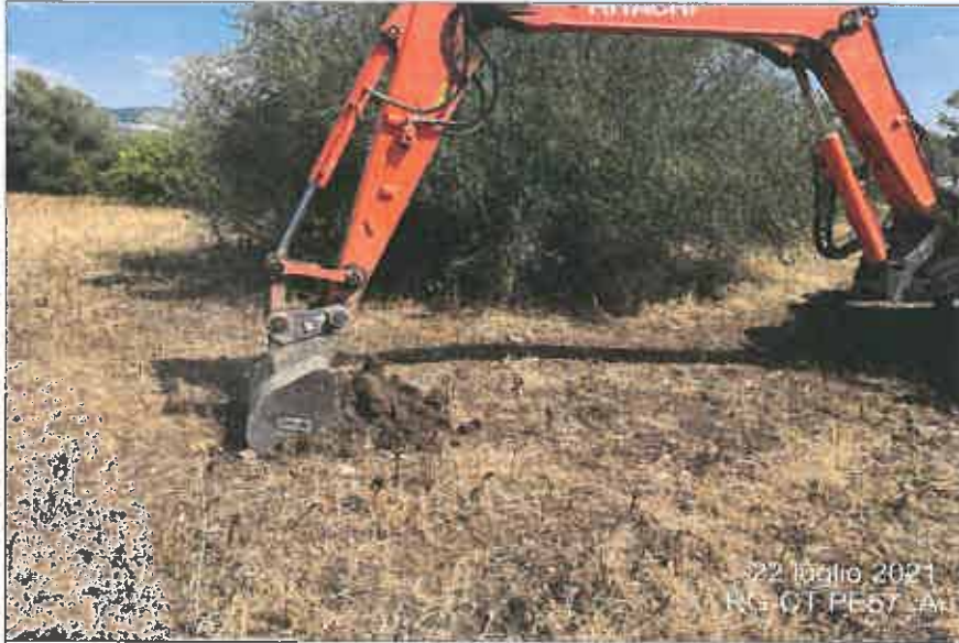
Ubicazione pozzetto esplorativo
