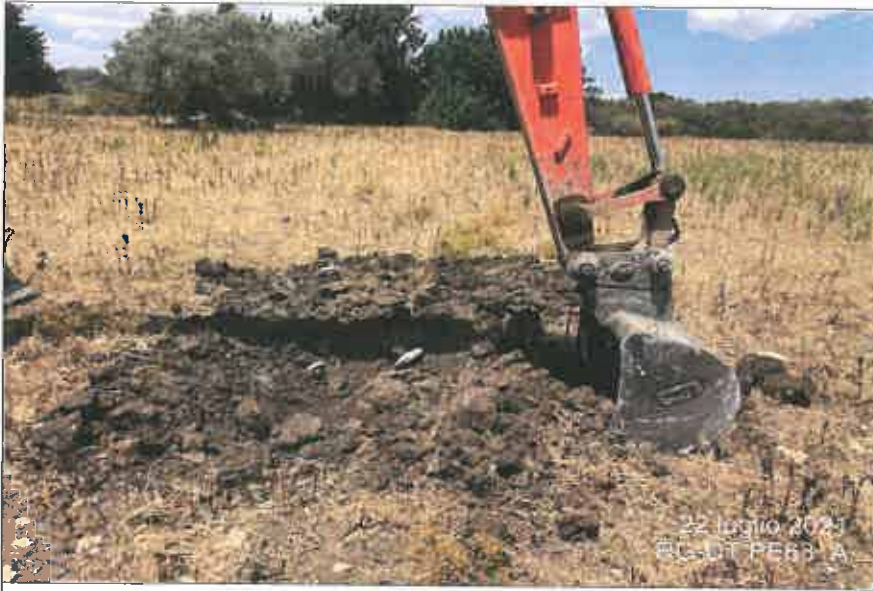
Ubicazione pozzetto esplorativo
