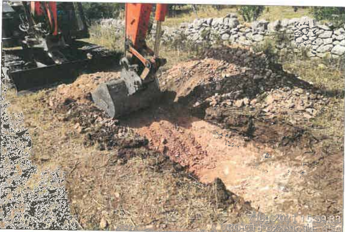
Ubicazione pozzetto esplorativo
