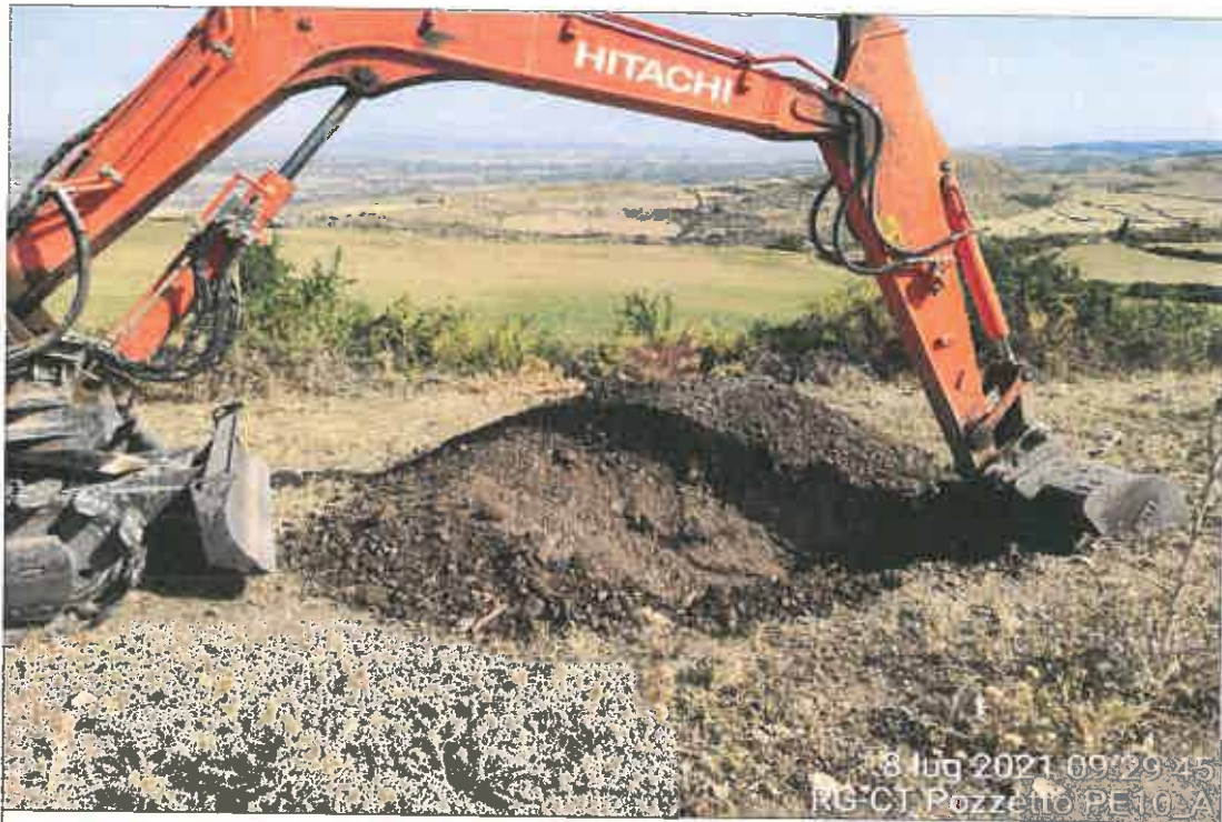
Ubicazione pozzetto esplorativo
