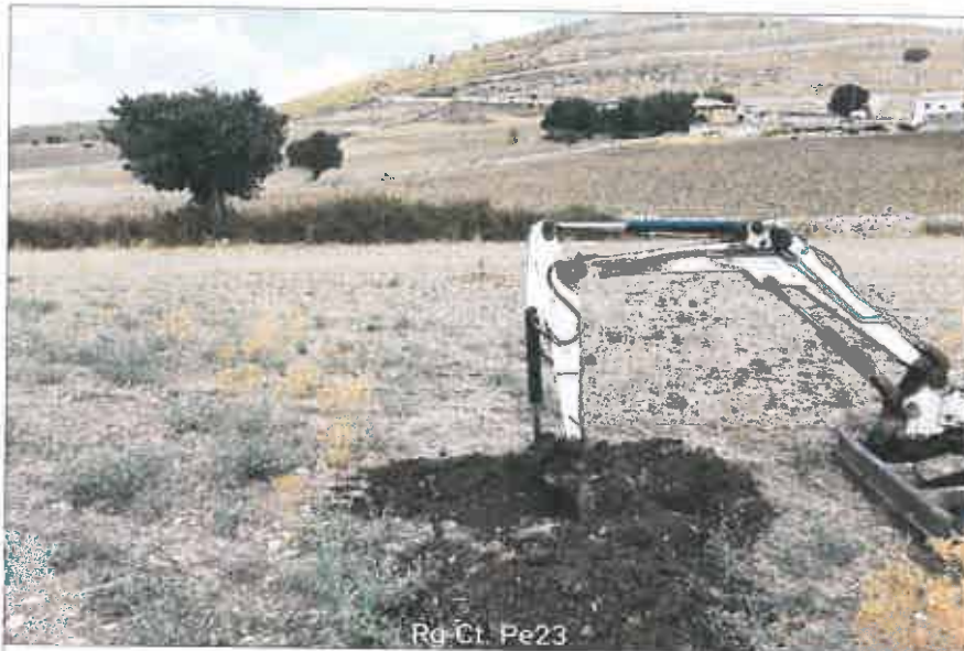
Ubicazione pozzetto esplorativo
