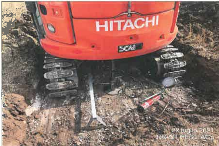
Ubicazione pozzetto esplorativo
