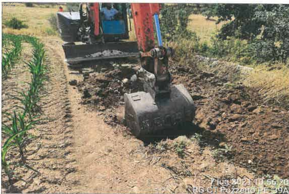
Ubicazione pozzetto esplorativo
