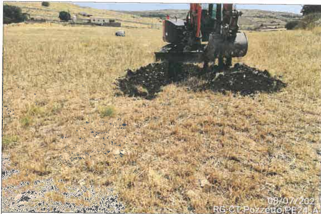
Ubicazione pozzetto esplorativo
