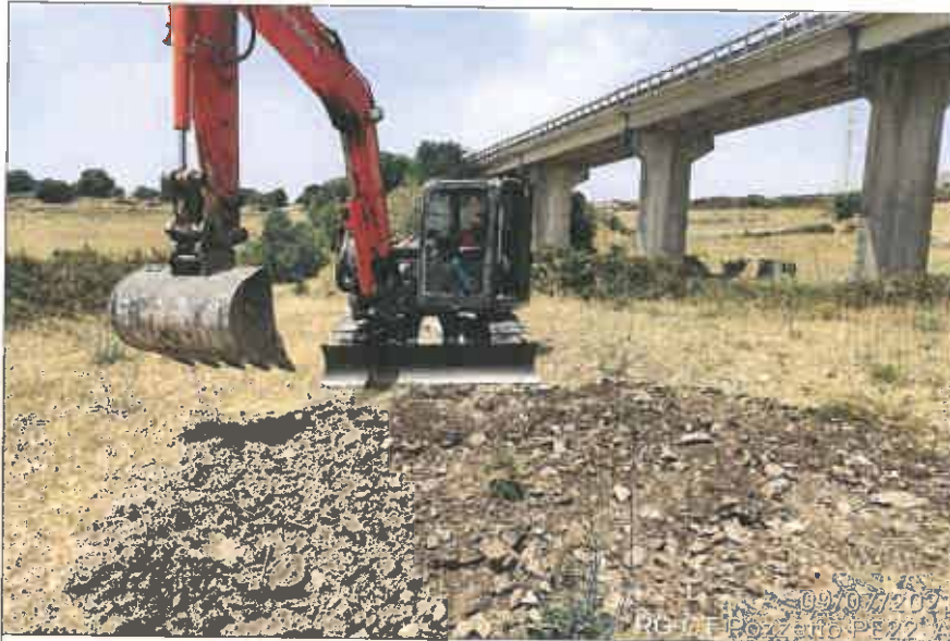
Ubicazione pozzetto esplorativo
