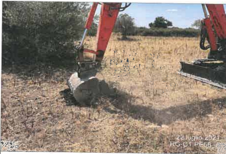
Ubicazione pozzetto esplorativo
