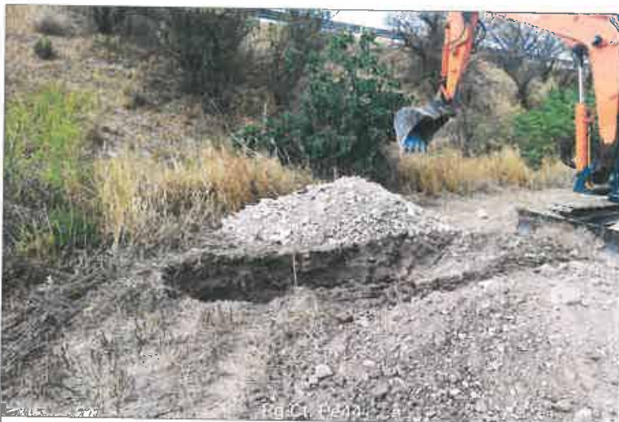
Ubicazione pozzetto esplorativo
