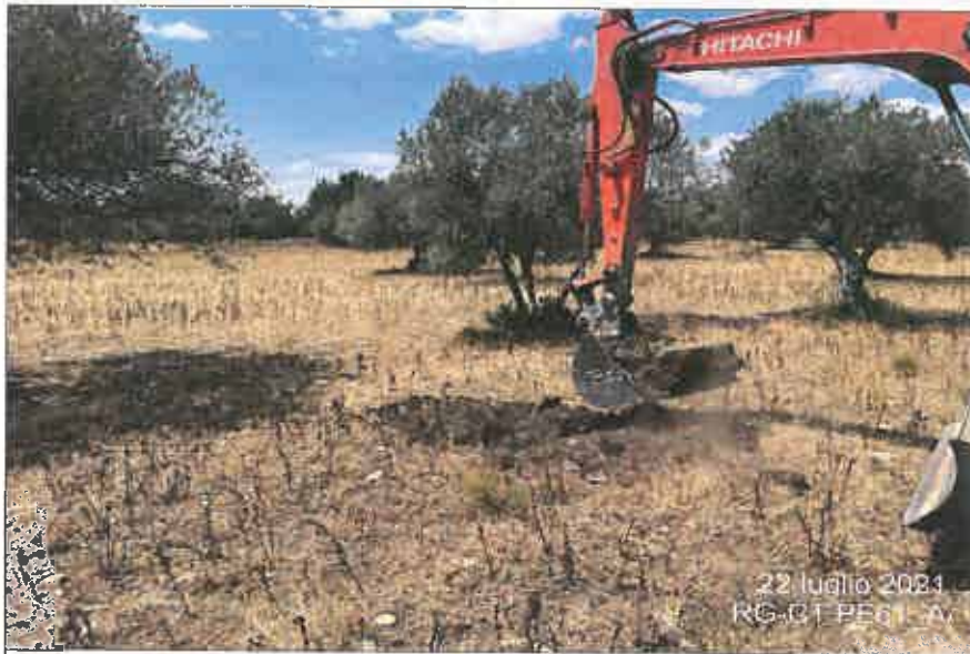
Ubicazione pozzetto esplorativo
