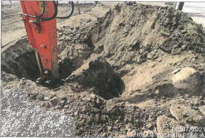
Ubicazione pozzetto esplorativo
