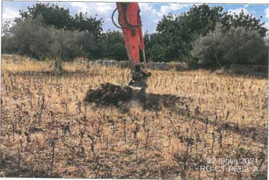
Ubicazione pozzetto esplorativo
