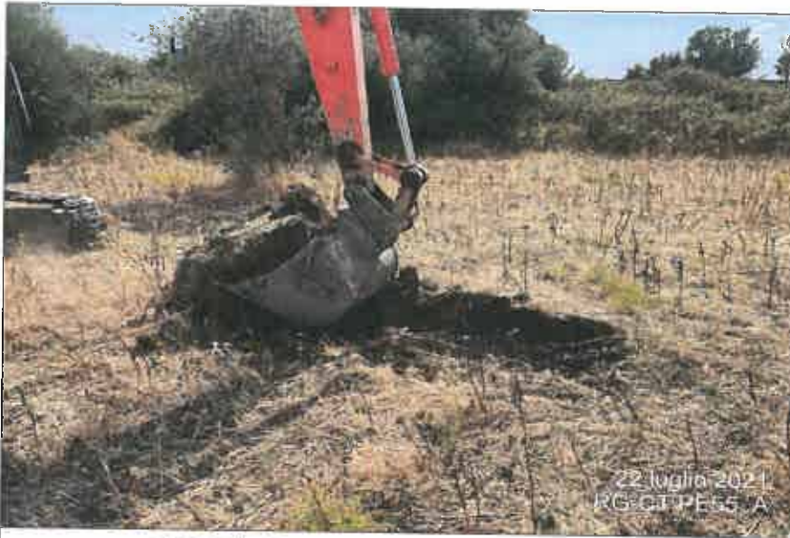
Ubicazione pozzetto esplorativo
