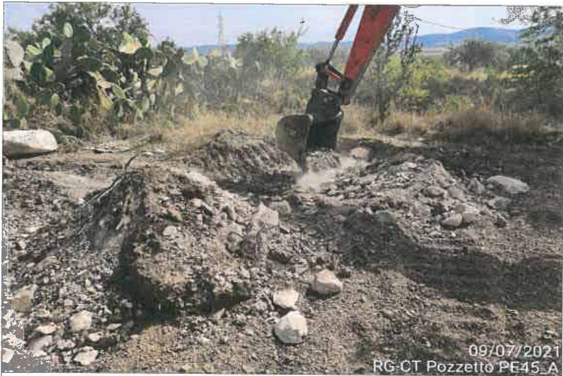
Ubicazione pozzetto esplorativo
