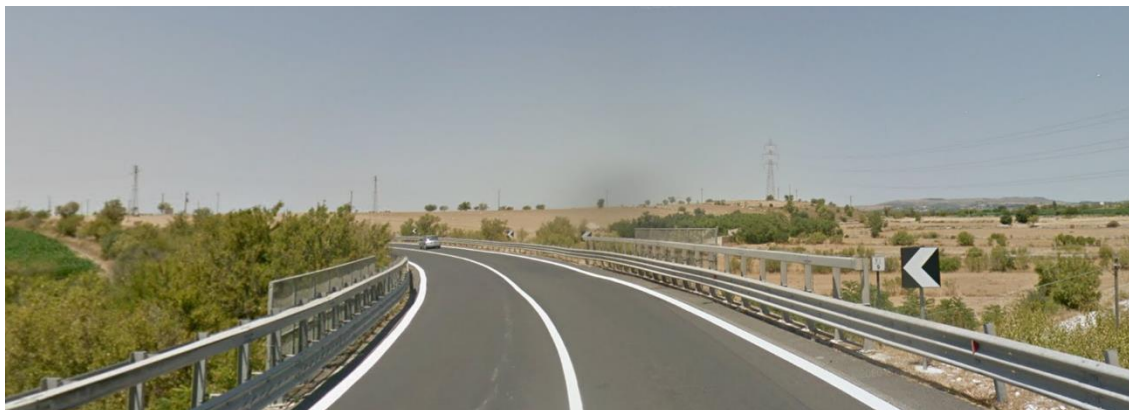
Figura 4 Strada Statale S.S. 514 in corrispondenza del cavalcavia sulla S.P. 77
