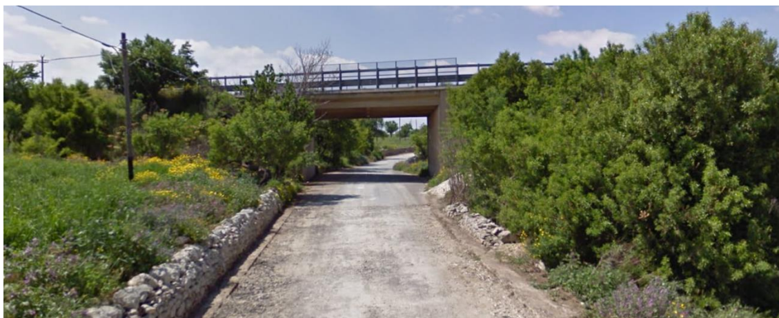
Figura 5 Strada Provinciale S.P. 77 in corrispondenza del cavalcavia della S.S. 514
