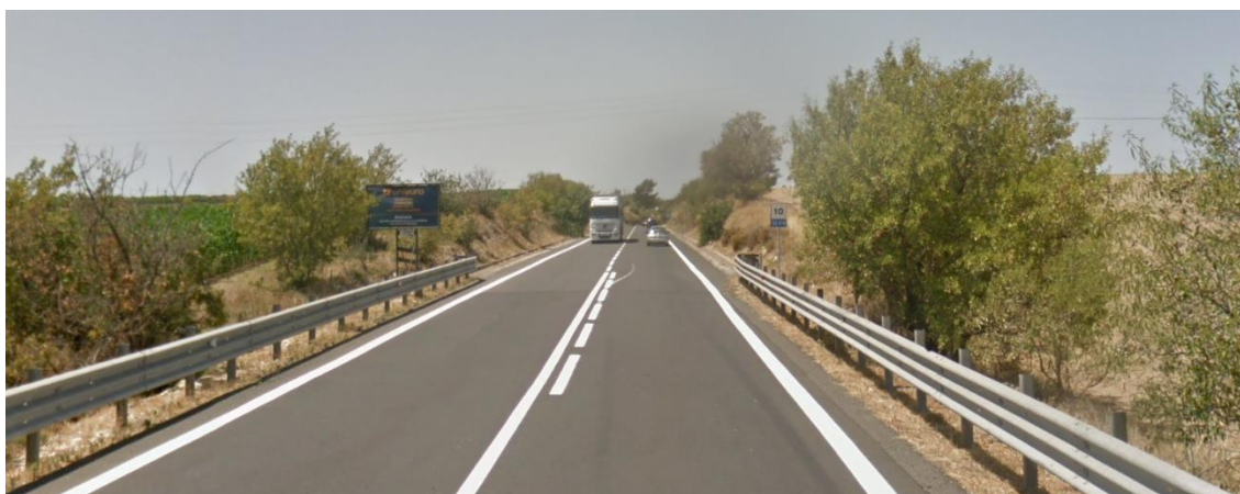
Figura 6 Strada Statale S.S. 514 a nord del cavalcavia sulla S.P. 77
