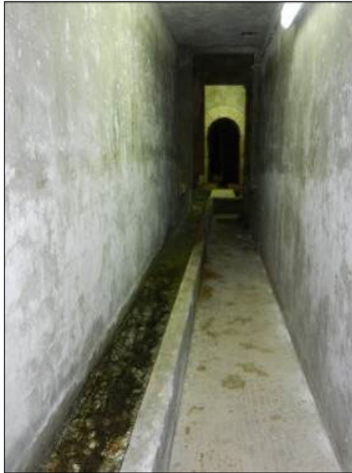
Foto 2-3 Ripresa interna dell'opera di captazione della sorgente Scianna Caporali
