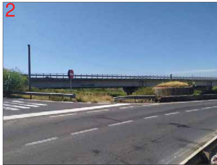
2 Punto di presa: Vista in direzione sud-ovest, ad una altezza più bassa rispetto al viadotto in progetto. Intervisibilità: Viabilità esistente - SS194. Percezione del manufatto parziale.
