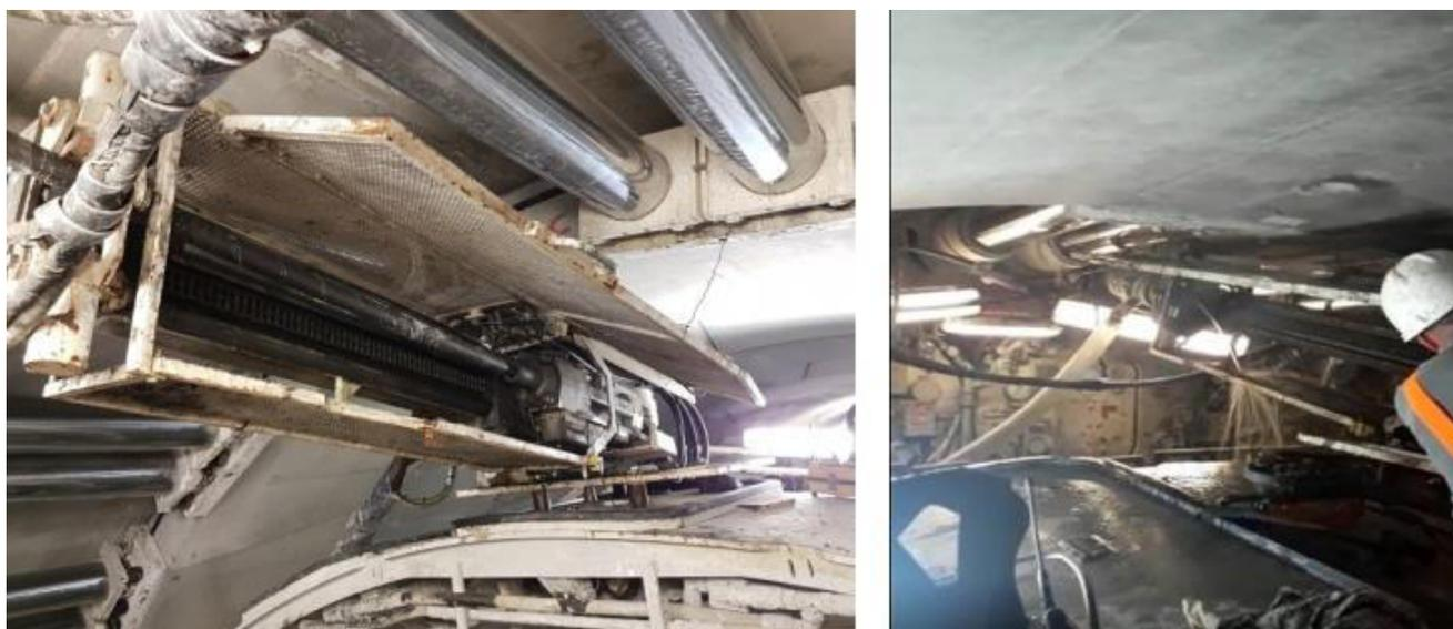
**Figura 4.2. Esecuzione di perforazioni in avanzamento sulla TBM S-979**
