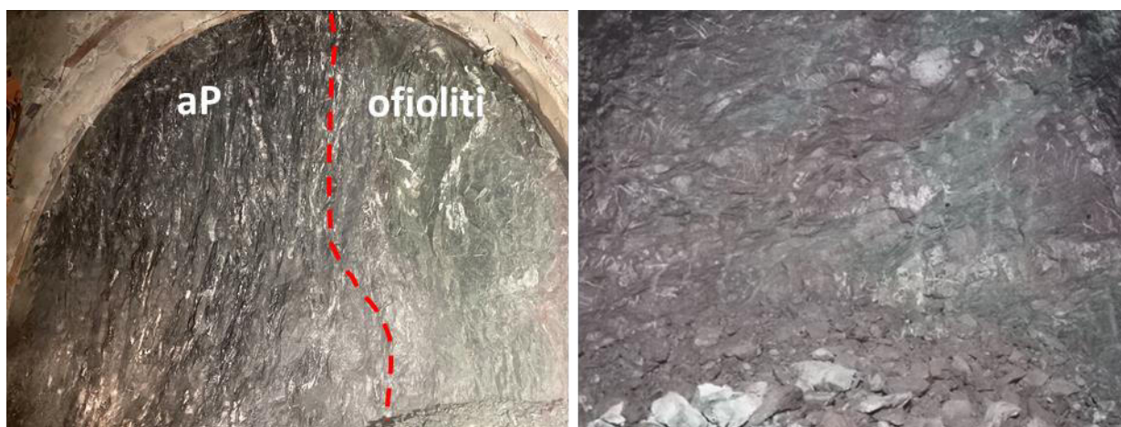
Figura 6-13. Fronti di scavo costituiti da fronti misti (sinistra) o Metabasalti competenti (destra)
