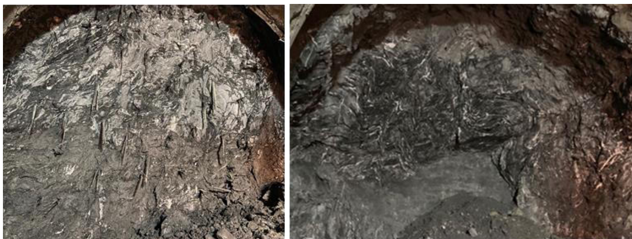
Figura 6-12. Fronti di scavo costituiti da Argille a Palombini con venature calcitico/quarzitiche
