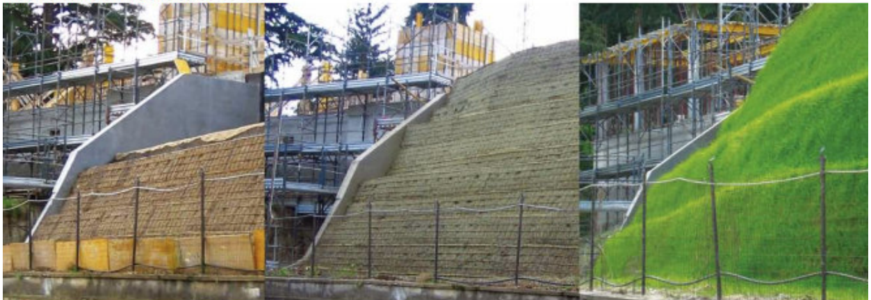
Figura 3: Fasi di esecuzione terre rinforzate
