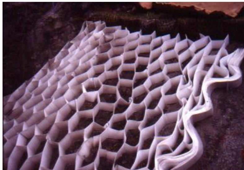
Figura 5 -stesura geocelle a nido d'ape- Foto G. Sauli
