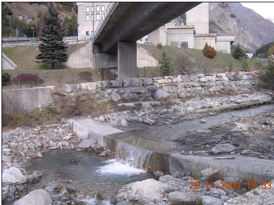
Fig.3 - Briglia in calcestruzzo armato da riconvertire.
