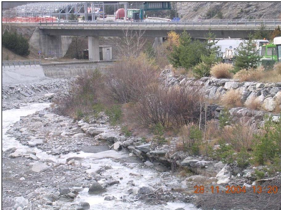
Fig. 1 - Platea di massi e calcestruzzo in parte erosa.
