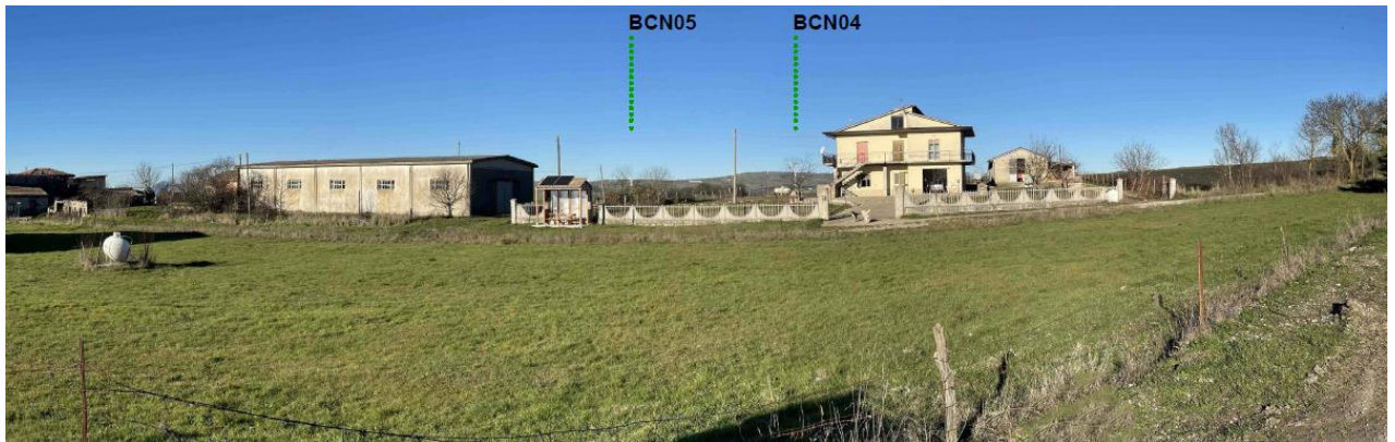
Figura 61- STATO DEI LUOGHI EX POST - ID 8
