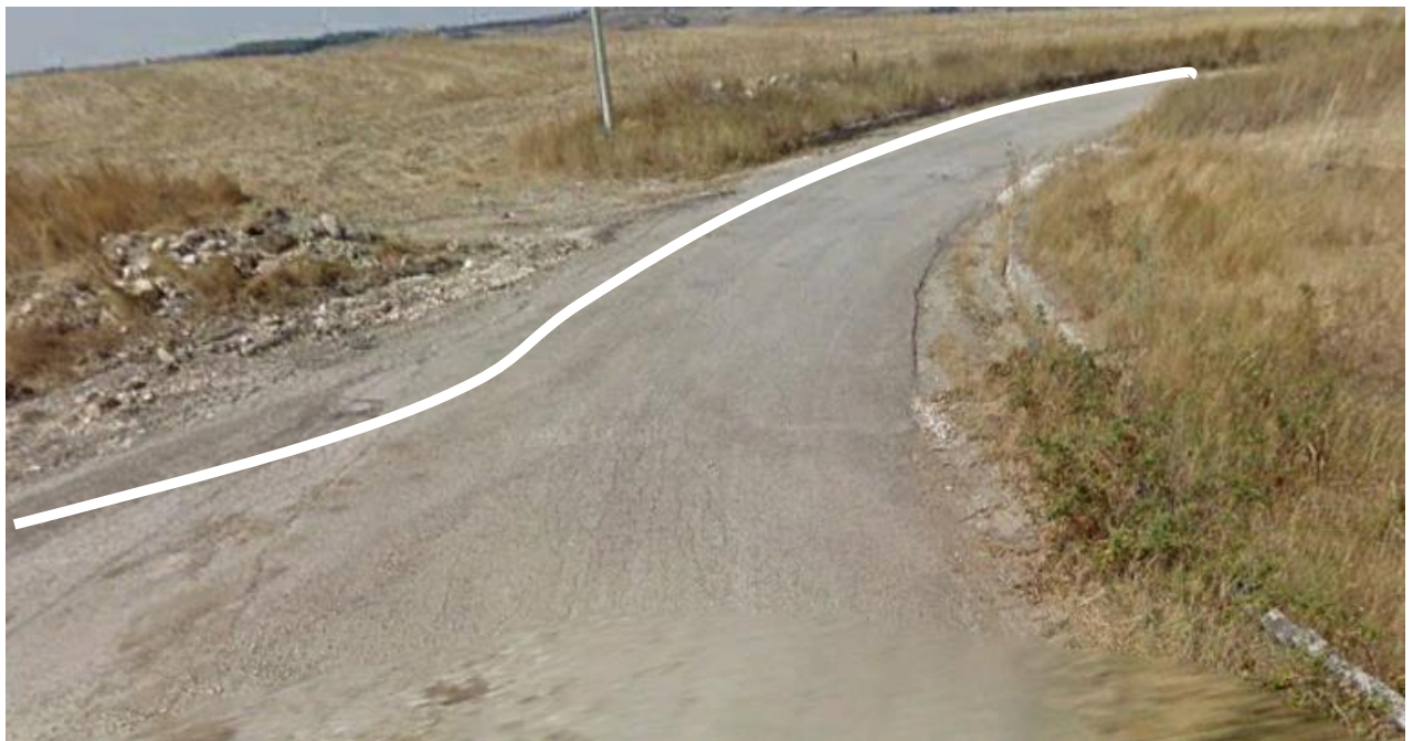
Figura 18- Ultimo tratto del cavidotto sulla sede stradale del tratturello con deviazione verso la BCN 04.
