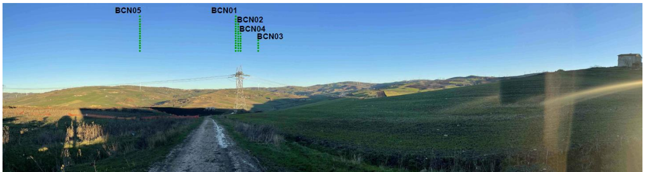
Figura 38- stato dei luoghi ex post ID 3
