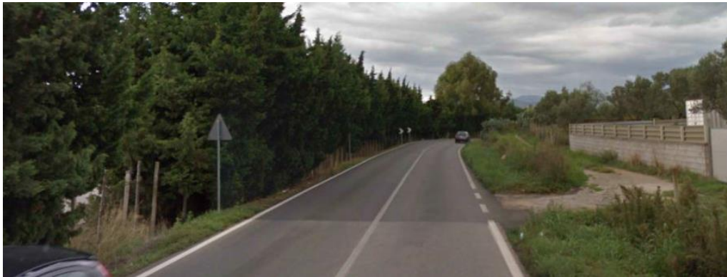
Stato Attuale S.P. 16 – Accessi privati non segnalati e presenza di alberi ad alto fusto a distanze non compatibili
