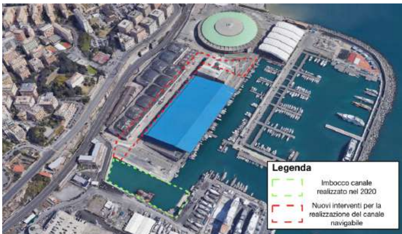
Figura 1 – Immagine aerea dell'area interessata dagli interventi a completamento del nuovo canale navigabile
