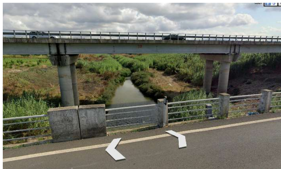
Figura 5-32. Vista del viadotto esistente della SS 114 sul fiume San Leonardo, ripreso dalla SS 194 (fonte Google Earth)
