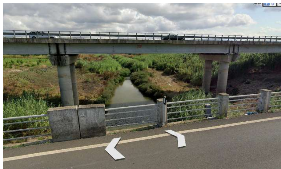
Figura 5-3. Vista del viadotto esistente della SS 114 sul fiume San Leonardo, ripreso dalla SS 194 (fonte Google Earth)
