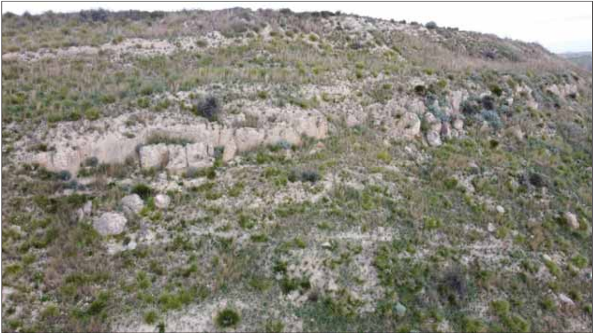
Foto 6-7 area di distacco, sulla scarpata è stata eseguita la Stazione Geomeccanica Sge3
