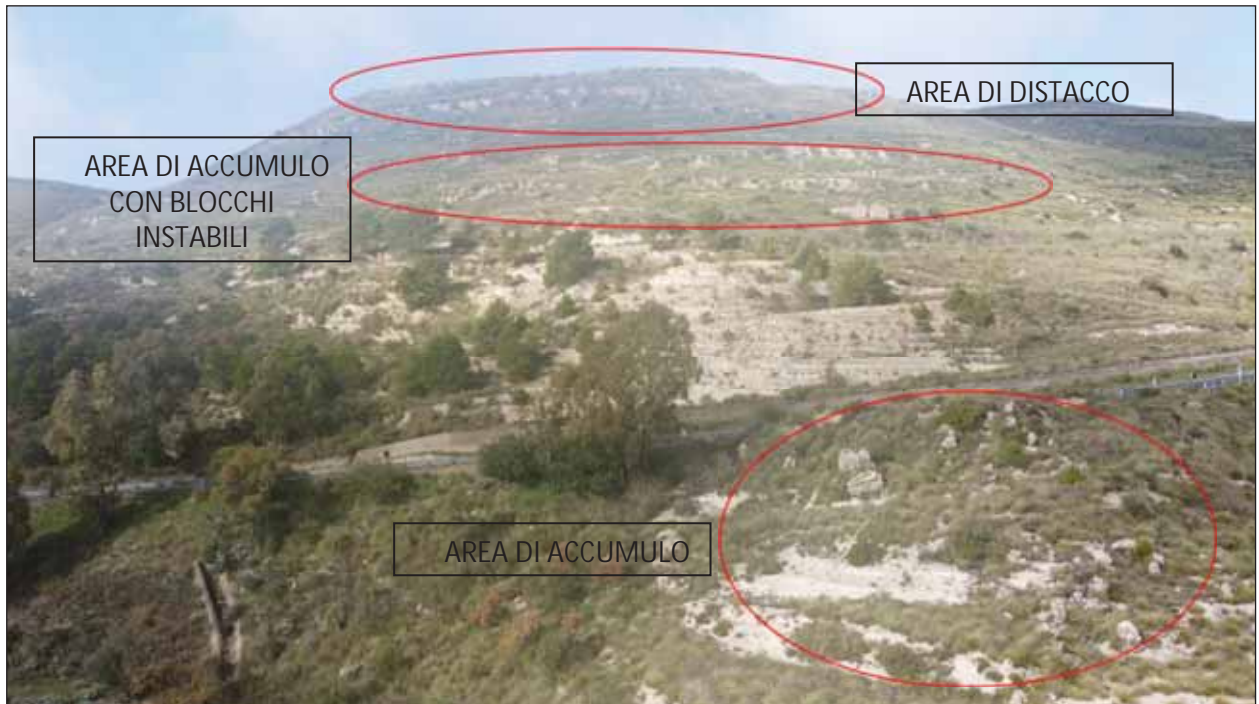
Foto 6-6 panoramica area coinvolta in frana L3_2
