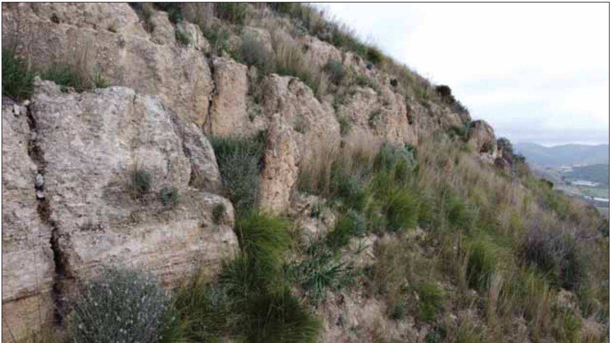
Foto 6-8 area di distacco, dettaglio blocchi instabili cinematicamente compatibili a fenomeni di ribaltamento per discontinuità parallele al versante
