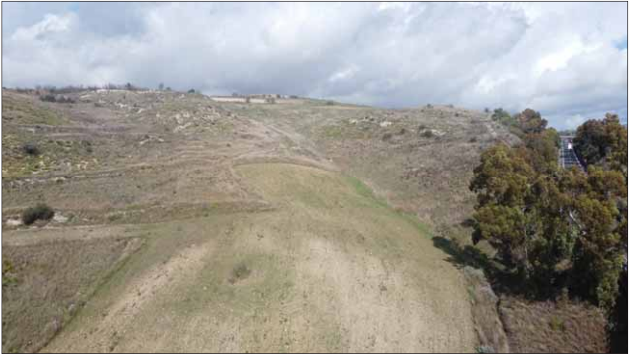
Foto 6-16 frana L3_3 vista valle
