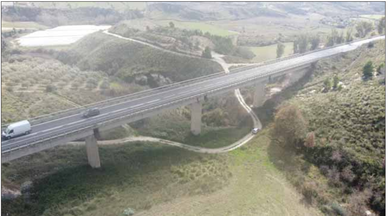
Foto 6-17 frana L3_3 con dettaglio interazione fosso Tenchio in incisione
