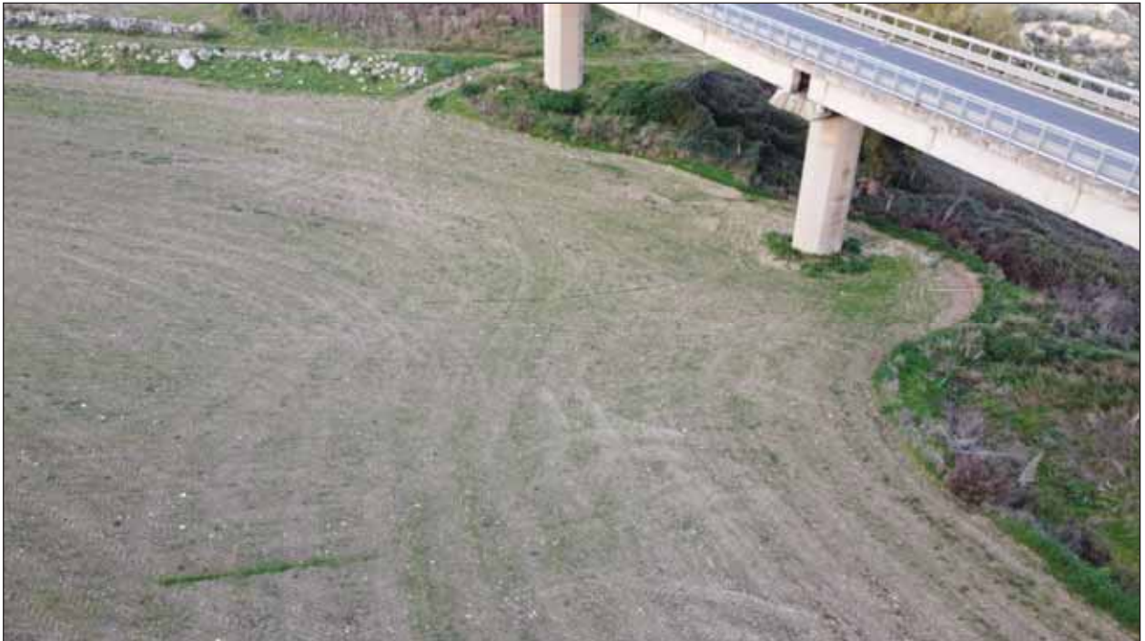
Foto 6-23 pile viadotto esistente coinvolte in fenomeno gravitativo, non sono stati riscontrati danni.
