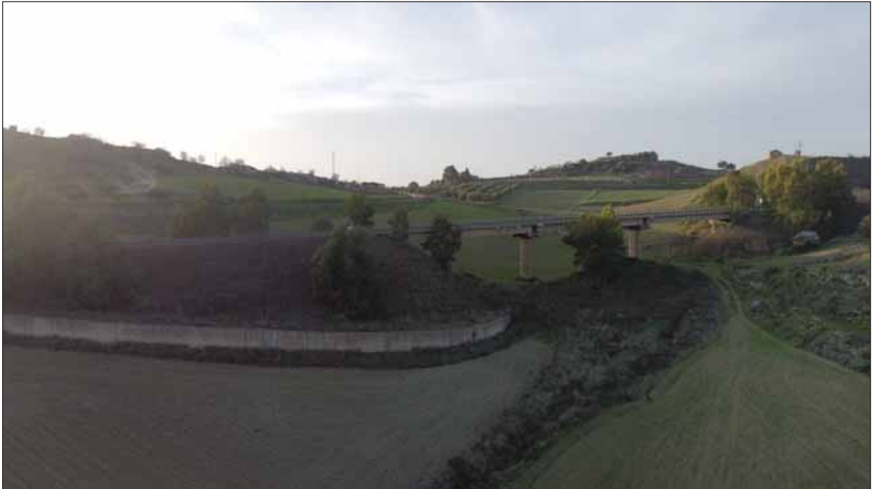
Foto 6-24 panoramica dissesto da valle, dettaglio del muro di sottoscampa del rilevato della spalla del viadotto esistente
