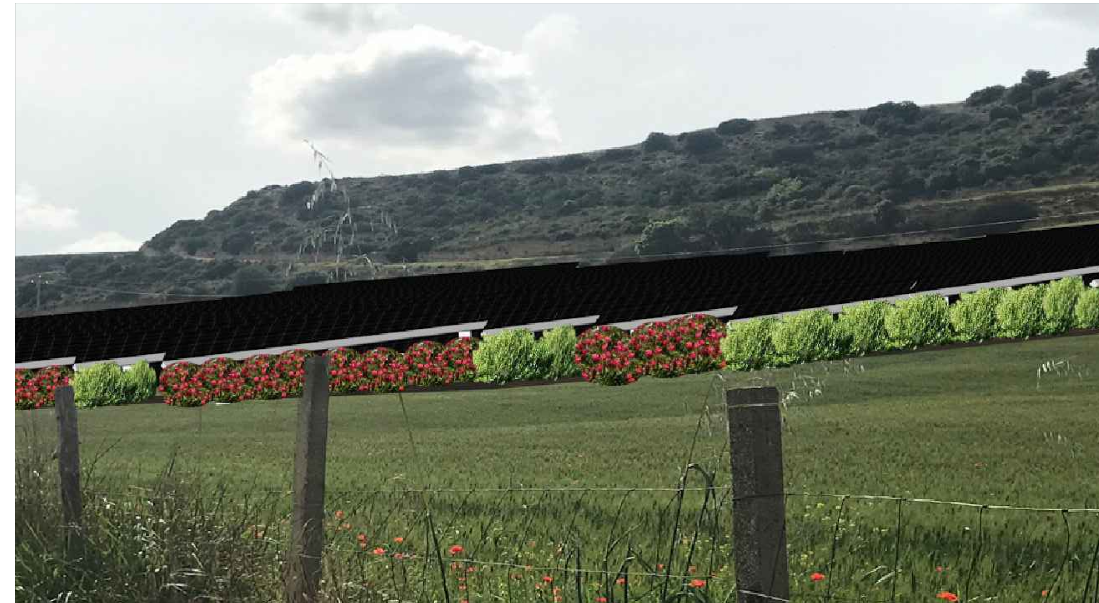
FOTO N.1 - AREA ESTERNA IMPIANTO - FILARI DI SULLA E ROSMARINO TRA I PANNELLI FOTOVOLTAICI
