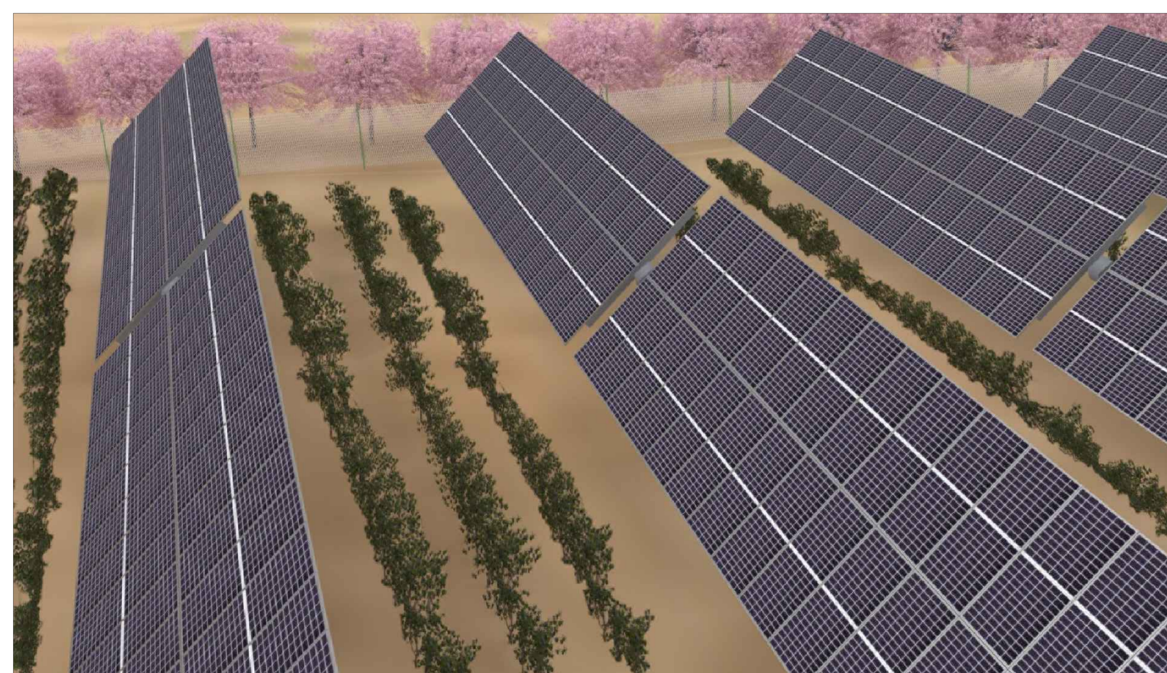
FOTO N.2 - AREA INTERNA IMPIANTO - COLTIVAZIONE E MITIGAZIONE
