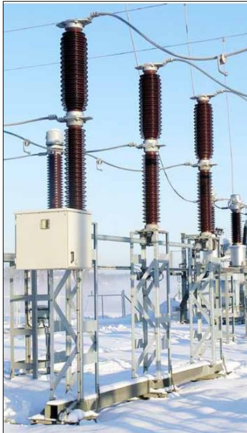
Fig. 15. Particolare Interruttore con TA incorporato.
