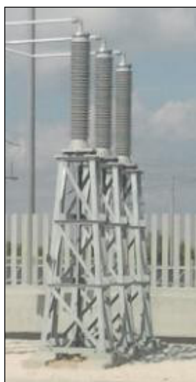
Fig. 11. Terminale cavo AT tipo.
