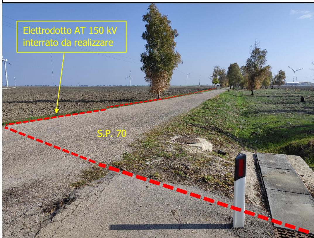
Foto n°10: Attraversamento su S.P. 70 al Km 13+768 elettrodotto AT verso Stazione Elettrica di Terna
