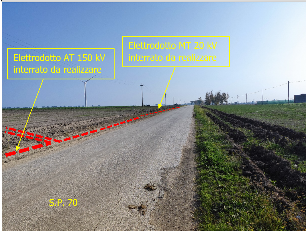
Foto n°9: Punto di partenza dell'elettrodotto AT interrato da realizzare
