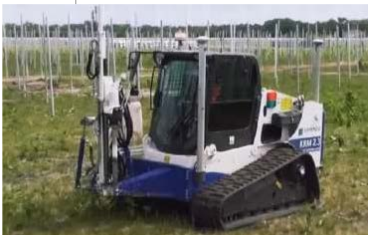
Figura 7. Esempio di fissaggio delle strutture di supporto
