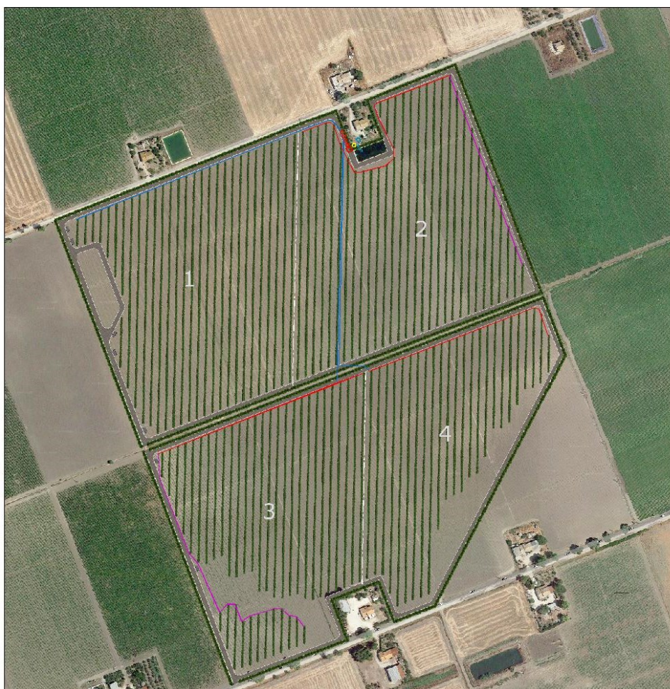
Impianto integrato e superfici nette
