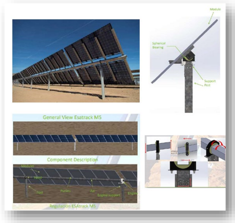
Figura 28 - Strutture di sostegno e sistema di inseguimento solare
