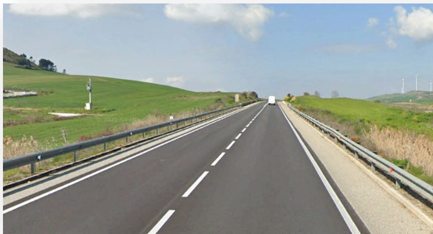
Figura 18 - Strada di accesso al parco SS96
