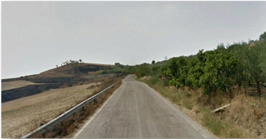
Figura 19 - Strada di accesso al SP203
