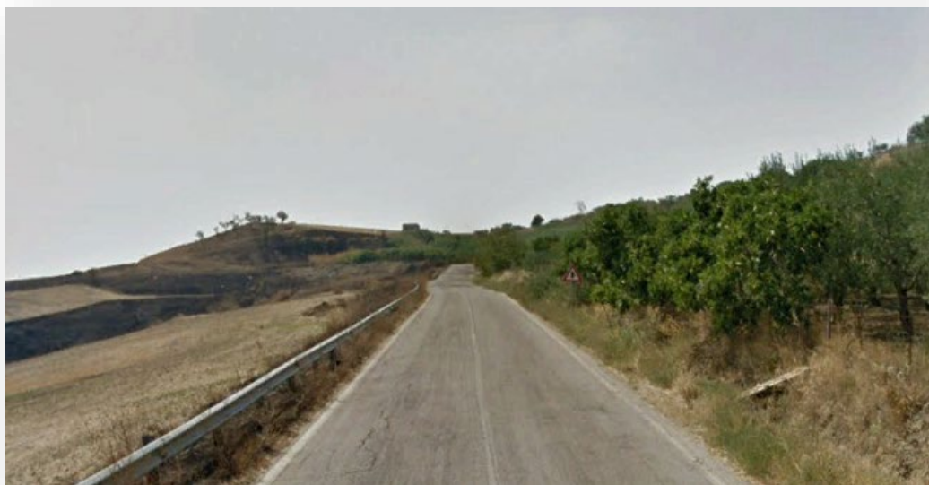
Figura 5 - Strada di accesso al SP203
