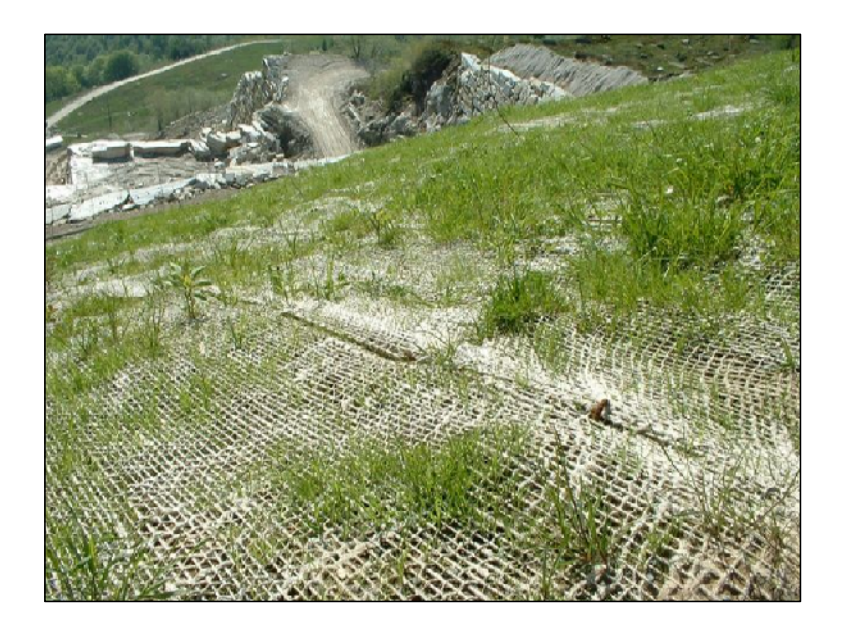
ESEMPIO DI POSA DI RETE IN FIBRA NATURALE DI JUTA
