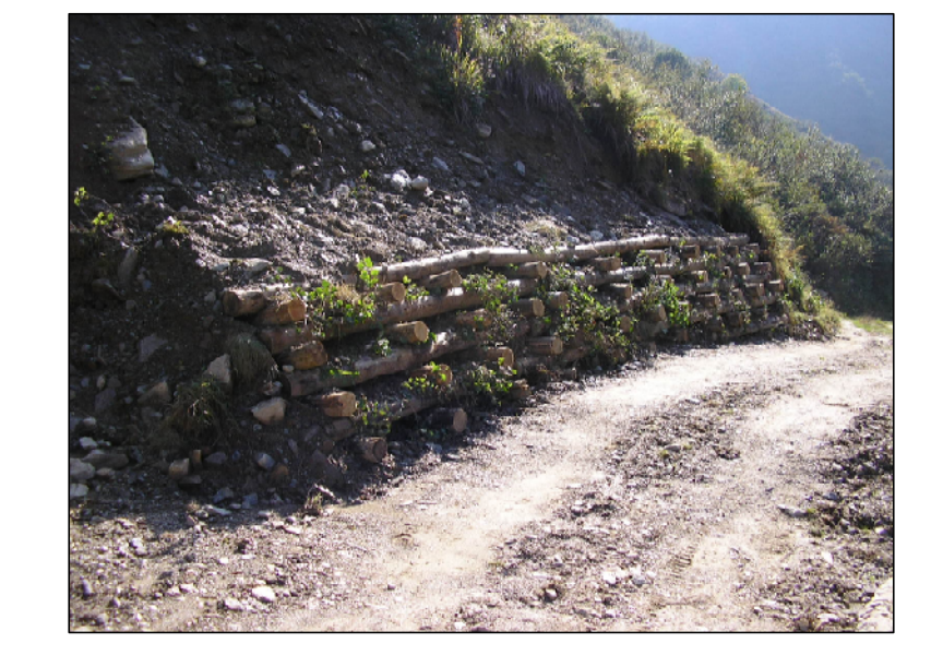
ESEMPIO DI PALIFICATA DI SOSTEGNO CON TALEE
